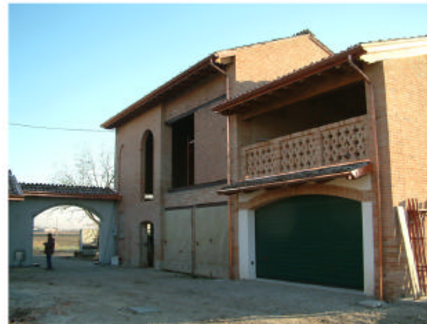
5. Edificio 2. Fronte sud-ovest
