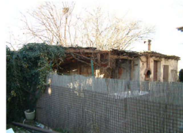
6. Edificio 3, Fronte nord-est
