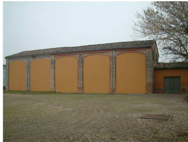
5. Edificio 3. Fronte est
