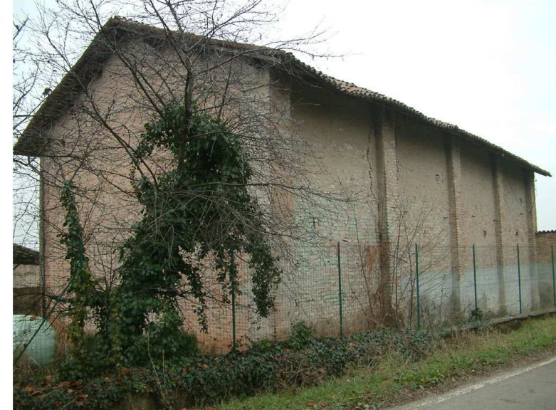
3. Edificio 2. Fronti sud ed est.
