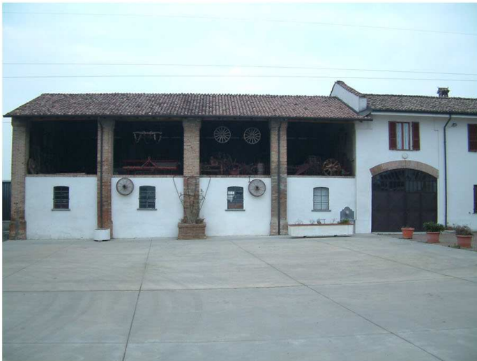
3. Edificio 1. Fronte sud.
