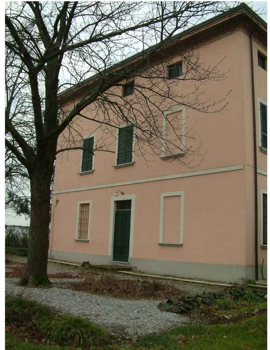
3. Edificio 1. Fronte est
