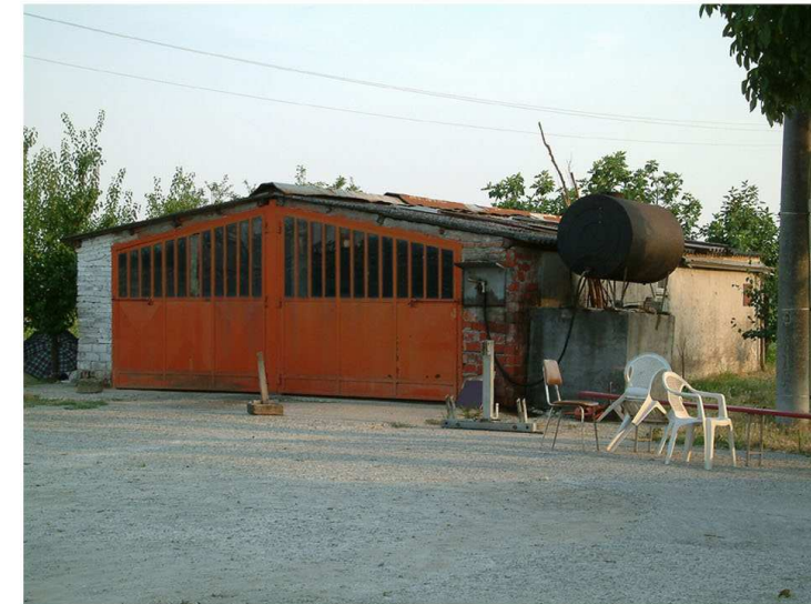
6. Edificio 5. Fronte nord.
