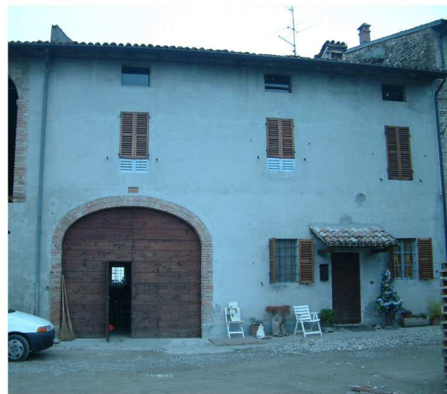
4. Edificio 1b-c. Fronte sud
