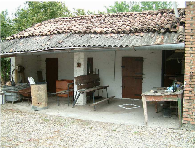
4. Edificio 2. Fronte sud.
