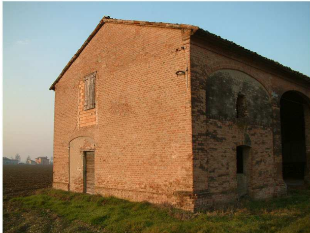
4. Edificio 2. Fronte sud-est
