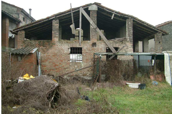
9. Edificio 3. Fronte est.
