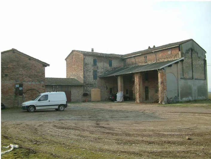
3. Edificio 1. Fronti nord ed est.
