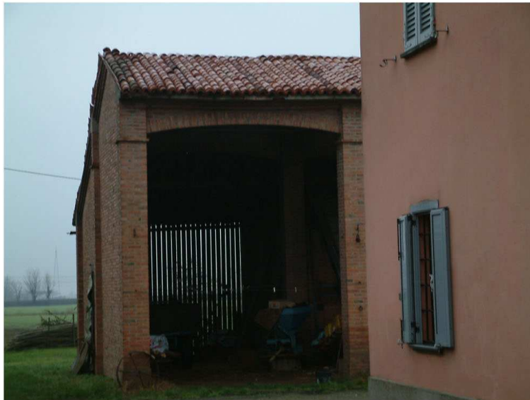
3. Edificio 2. Fronte sud.
