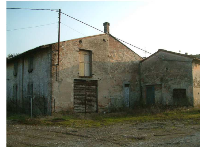
6. Edifici 1g-1a. Fronte ovest e nord
