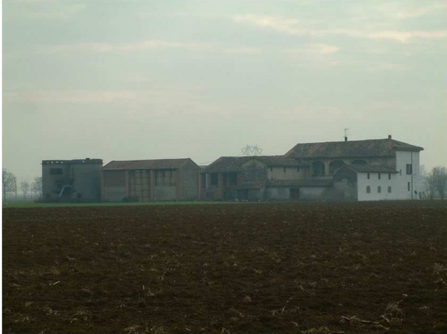
1. Vista del complesso da Nord.
