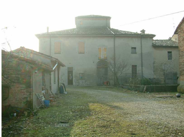
4. Edificio 1a. Fronte nord
