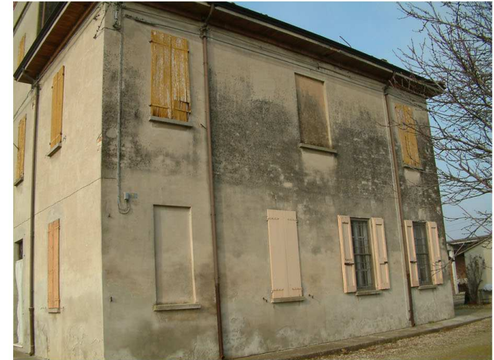
3. Edificio 1. Fronte est
