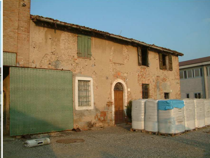
2. Edificio 1a. Fronte sud
