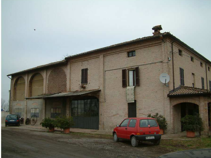
1. Edificio 1. Fronte sud.
