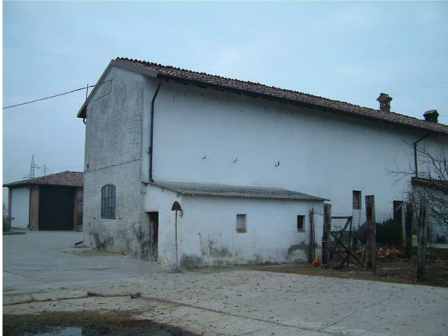
6. Edificio 1. Fronti sud ed est.
