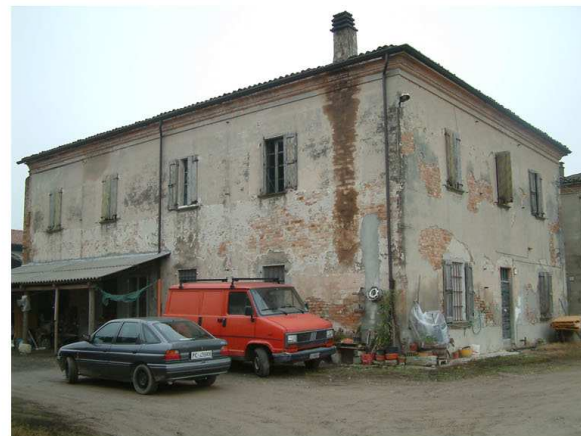
5. Edificio 3. Fronte nord-ovest
