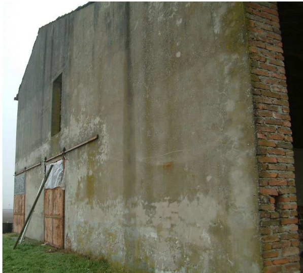
4. Edificio 1. Fronte sud-est.
