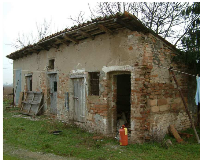
5. Edificio 3. Fronte ovest e sud.
