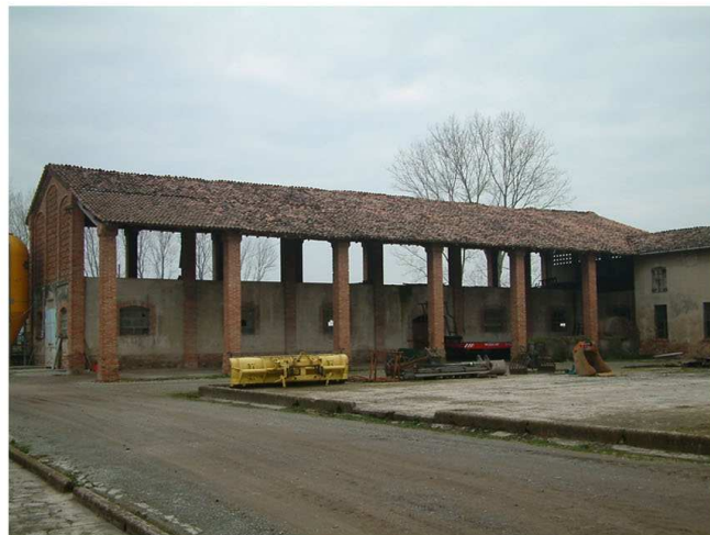
4. Edificio 3. Fronte nord
