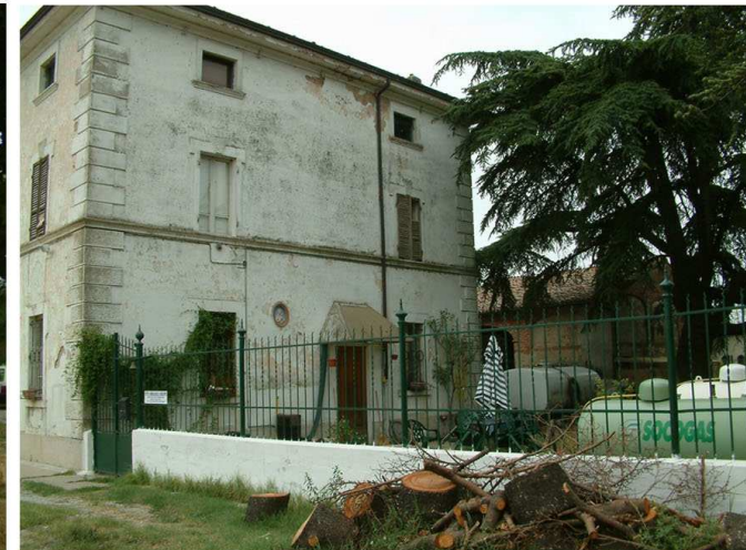
4. Edificio 1. Fronte est.
