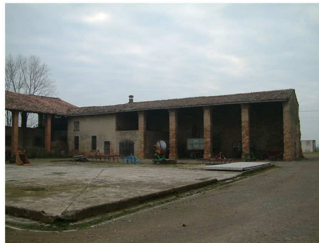
5. Edificio 3. Fronti nord ed est.
