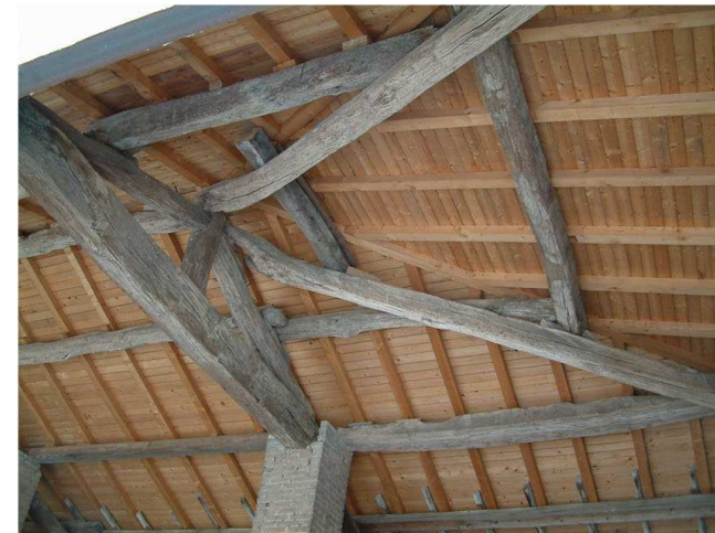
7. Edificio 2. Particolare copertura.
