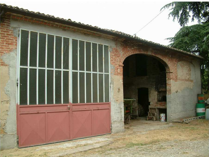
8. Edificio 3. Fronte sud.
