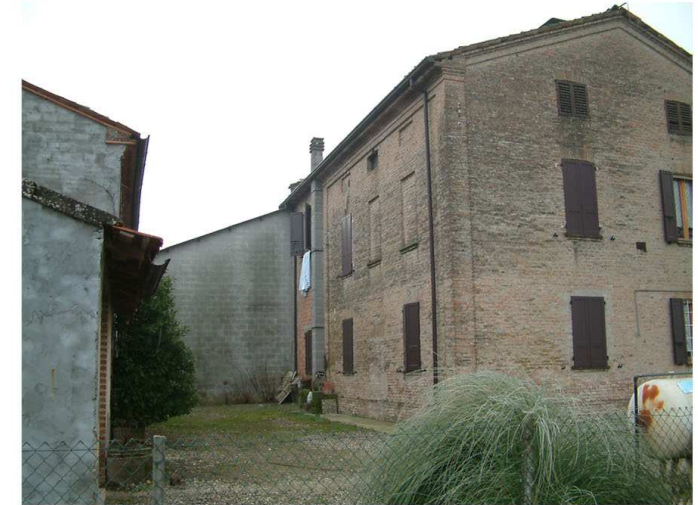
3. Edificio 1. Fronte nord
