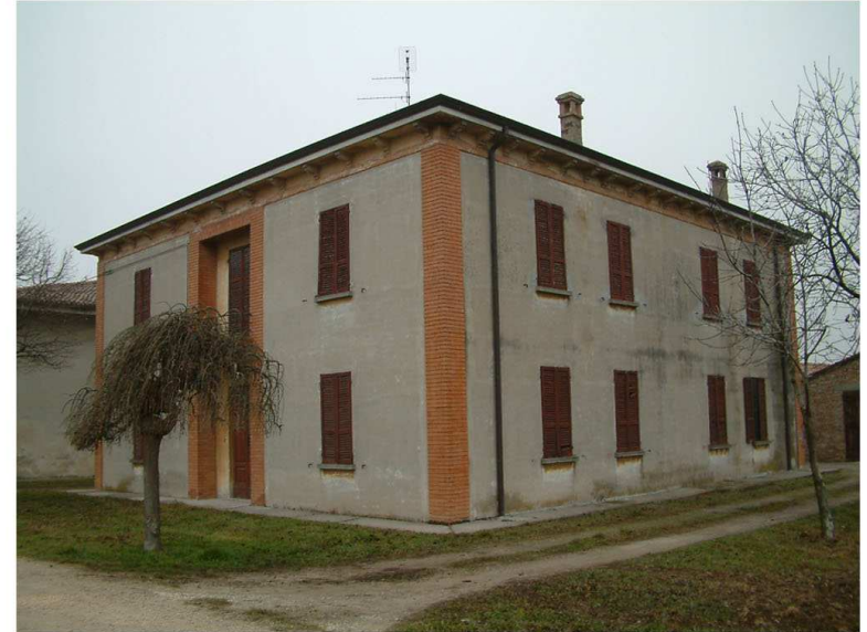
2. Edificio 1. Fronti sud e est.
