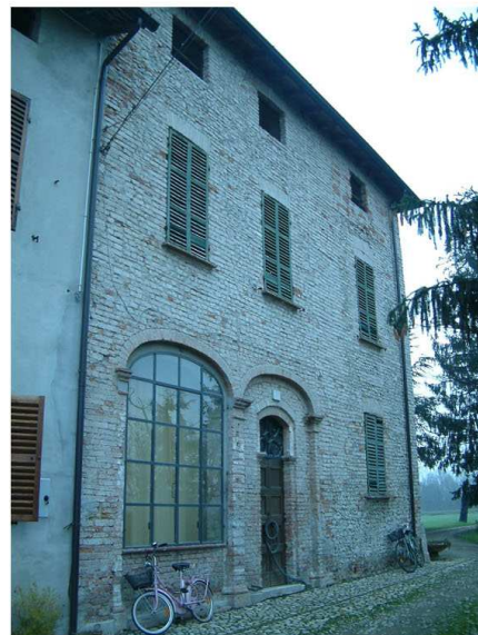
3. Edificio 1a. Fronte sud
