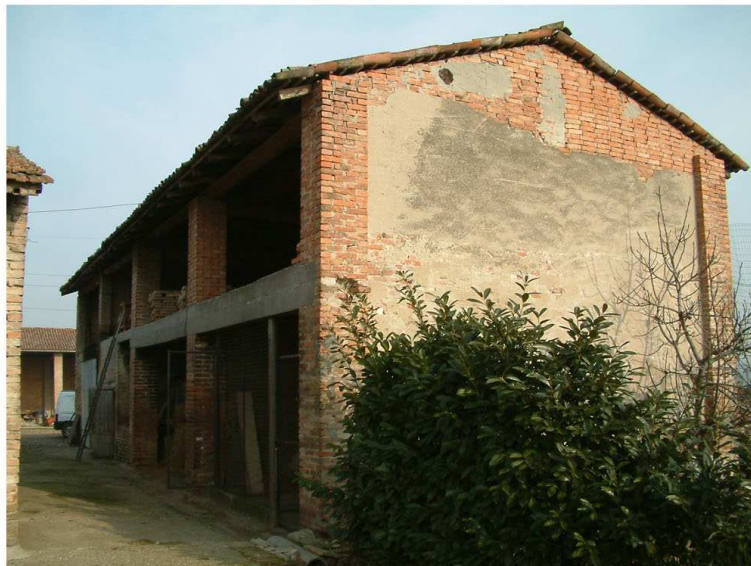
8. Edificio 2. Fronti est e sud.
