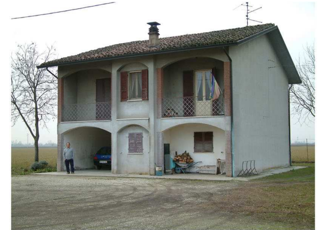
3. Edificio 2. Fronte nord
