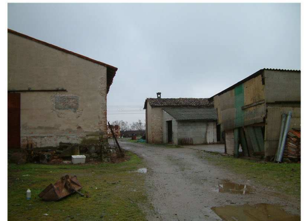
12. Edificio 2. Fronte sud
