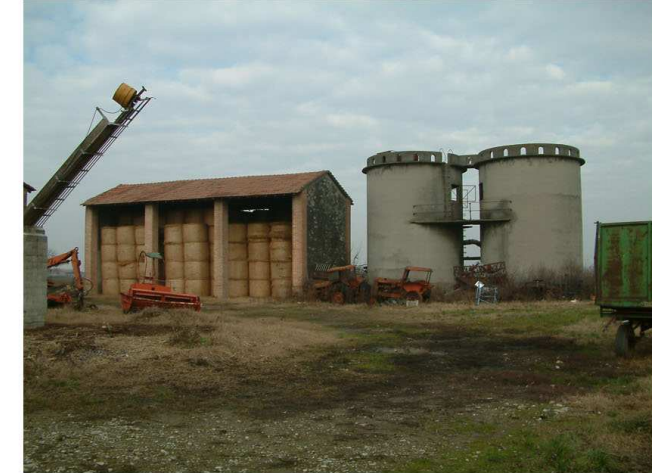
6. Edificio 2. Fronti sud ed est.
