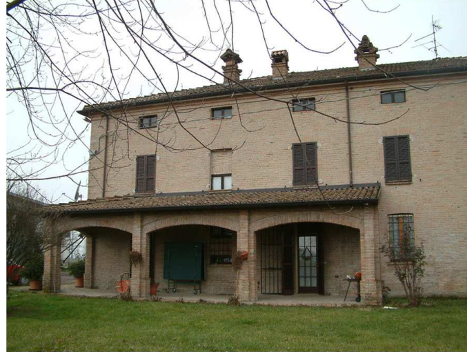
2. Edificio 1. Fronte est.
