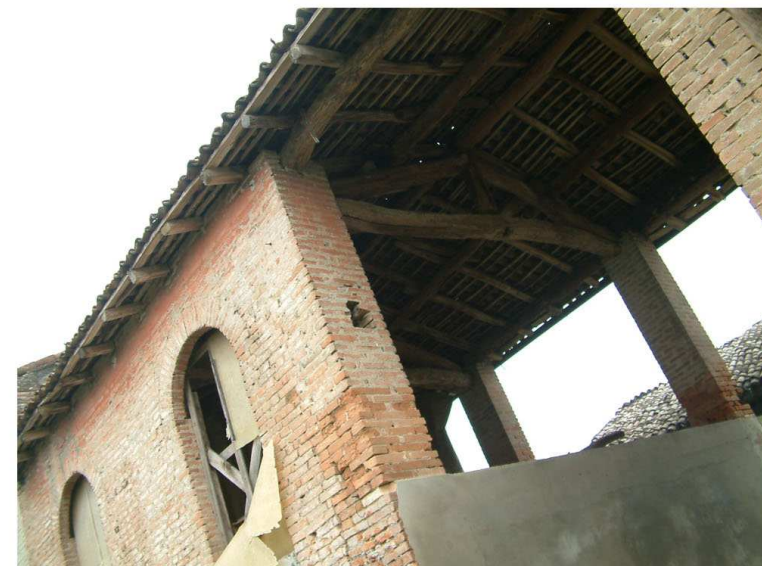
5. Edificio 1. Particolare del fienile.
