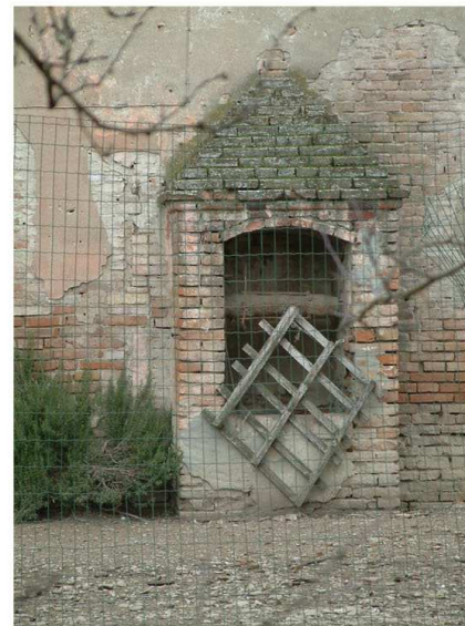
9. Pozzo accostato all'edificio 1 sul fronte sud.
