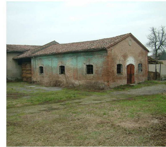
6. Edificio 1e+1f. Fronti sud ed est.
