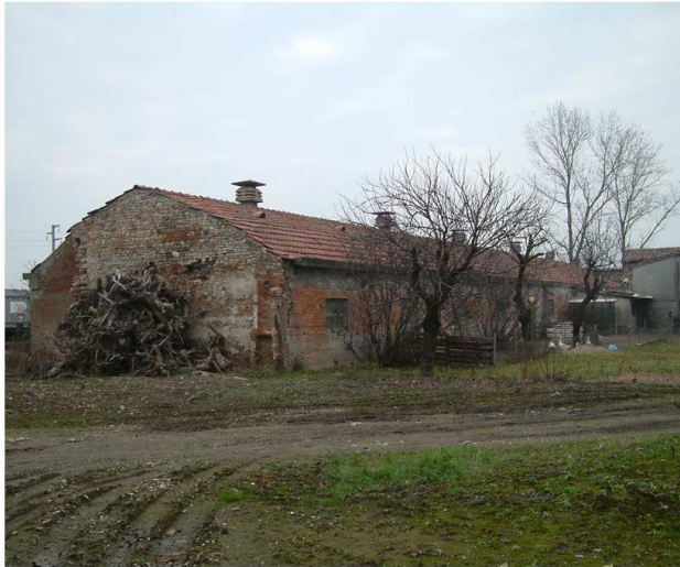
13. Edificio 6. Fronti sud ed est.
