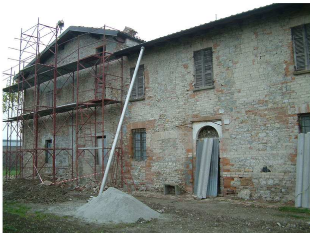
3. Edificio 1. Fronte est.
