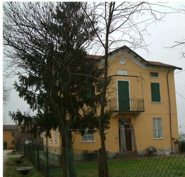
4. Edificio 2. Fronte sud.
