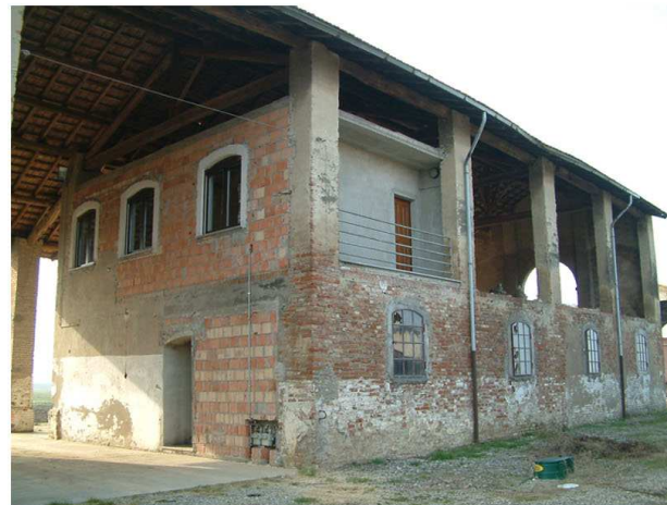
5. Edificio 1d. Fronte nord
