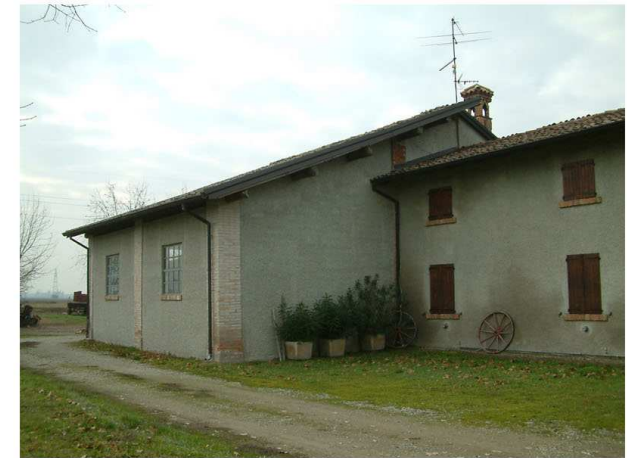
3. Edificio 1. Fronte nord: stalla
