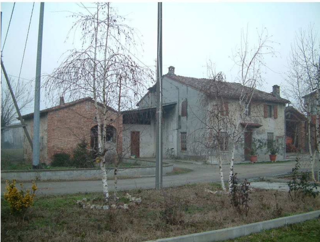
3. Edificio 1. Fronte sud.
