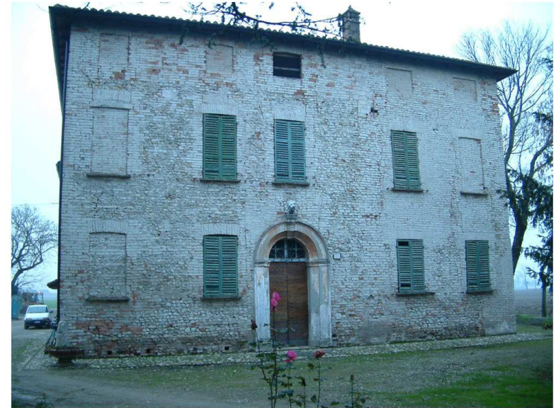
2. Edificio 1a. Fronte est
