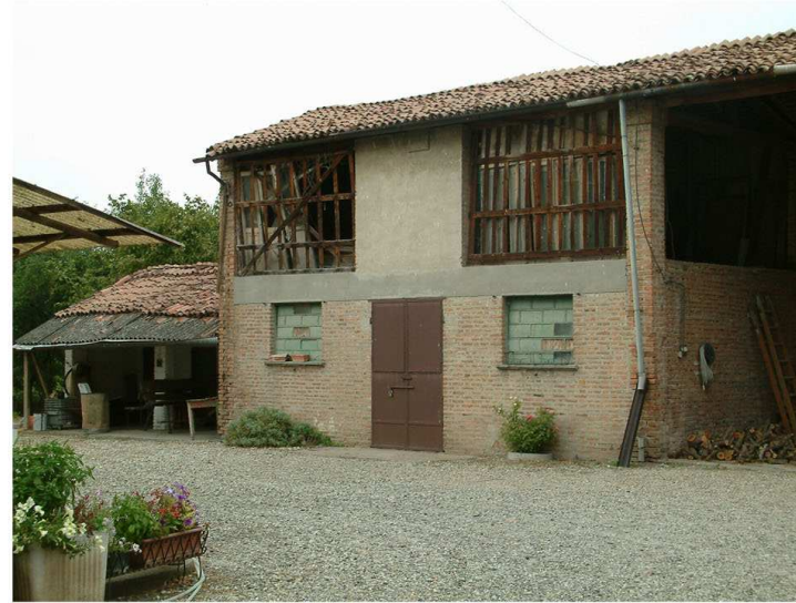
2. Edificio 2. Fronte sud.
