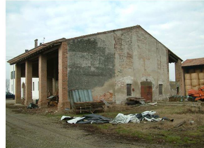
3. Edificio 1. Fronti sud ed est.
