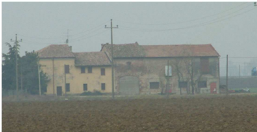
3. Edificio 1. Fronte est
