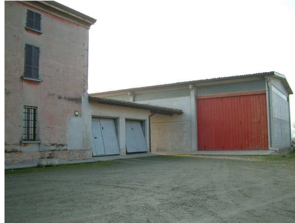
2. Edificio 1b. Fronte nord
