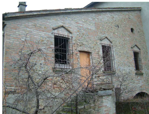
5. Edificio 1d. Fronte sud
