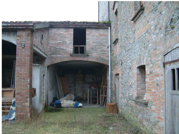
4. Edificio 1b. Fronte ovest
