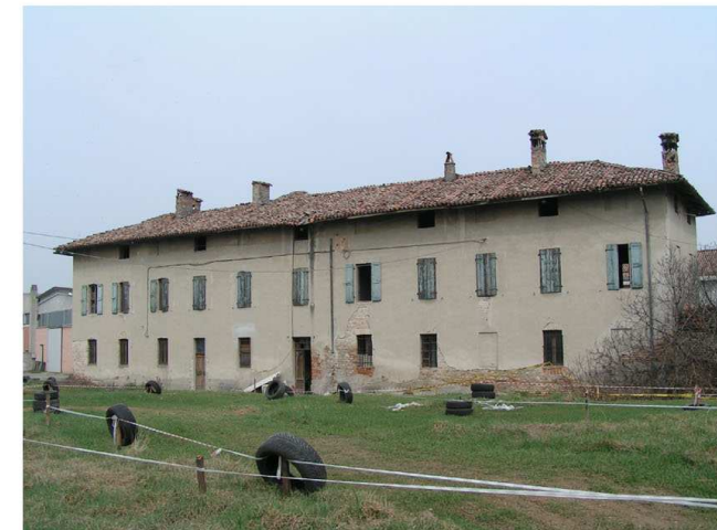
6. Edificio 1c. Fronte sud
