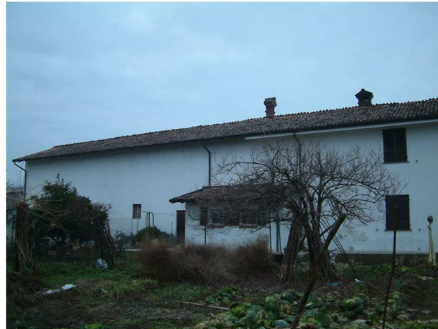
7. Edificio 1. Fronte est.
