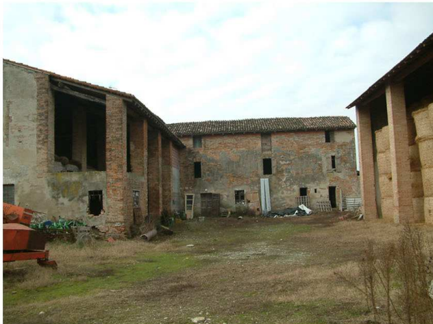
4. Edificio 1. Fronte est.
