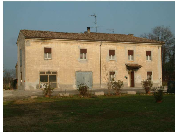
5. Edificio 4. Fronte sud
