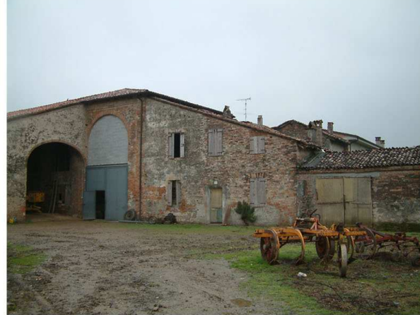
8. Edificio 1h-1i. Fronte est
