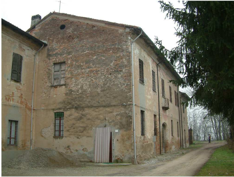
1. Edificio 1b. Fronti ovest e sud.
