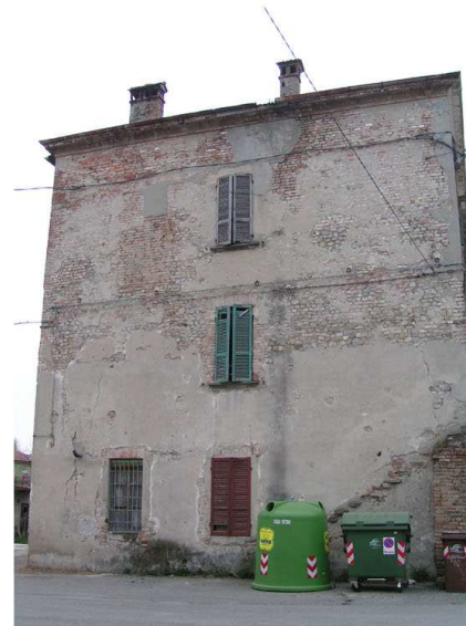
5. Edificio 1a. Fronte ovest
