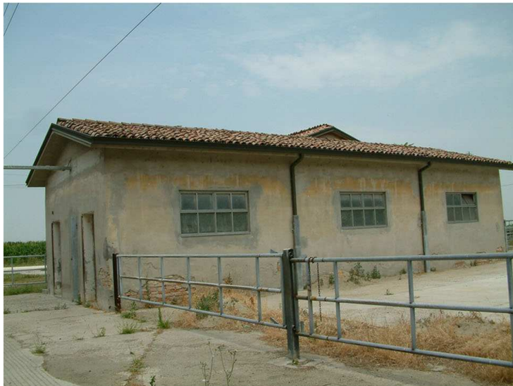
4. Edificio 2. Fronti sud ed est.
