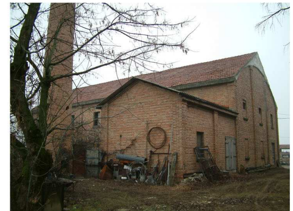
12. Edificio 7. Fronte est
