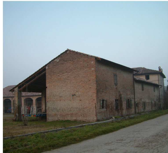
7. Edificio 3. Fronti sud e est.
