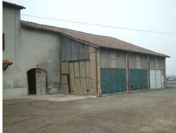
2. Edificio 1b-1c. Fronte est
