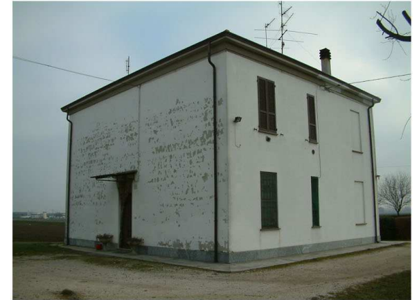
3. Edificio 1. Fronte sud-est
