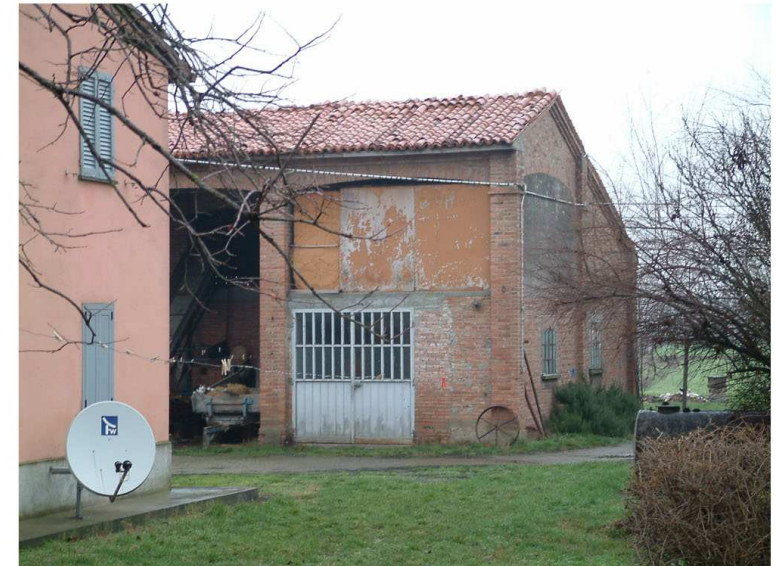
4. Edificio 2. Fronti sud ed est.
