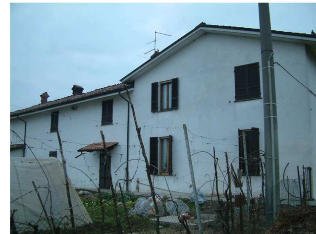
8. Edificio 1. Fronte est.
