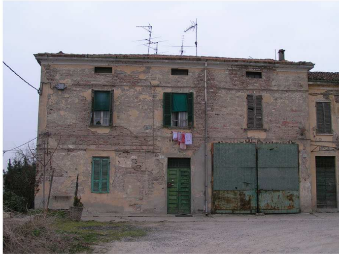
1. Edificio 1a. Fronte sud
