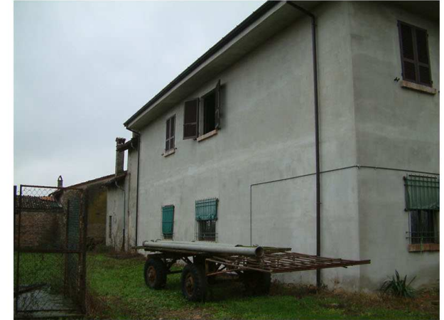
9. Edificio 1b. Fronte nord
