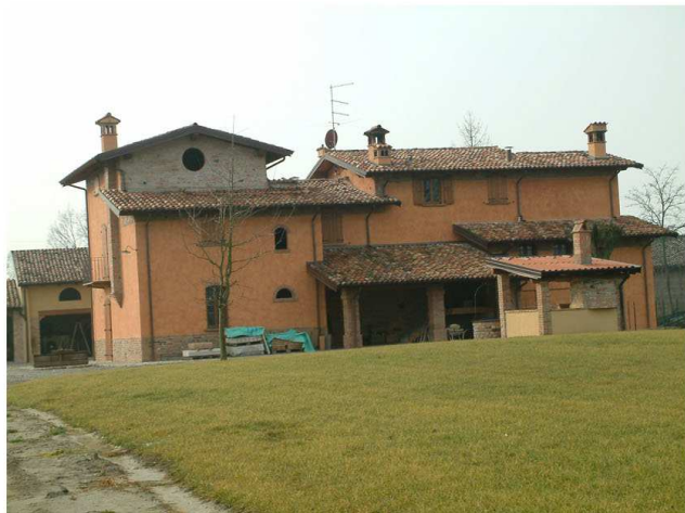
4. Edificio 1. Fronte nord
