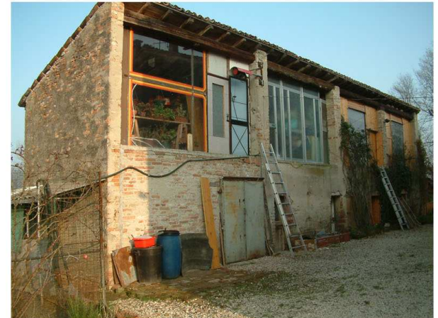
6. Edificio 5. Fronte sud
