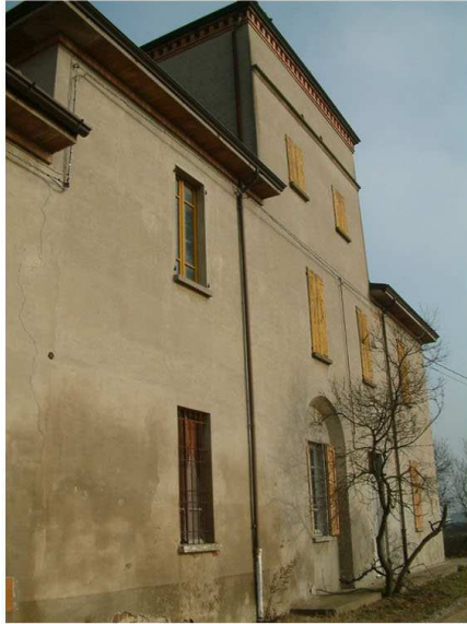
1. Edificio 1a. Fronte sud
