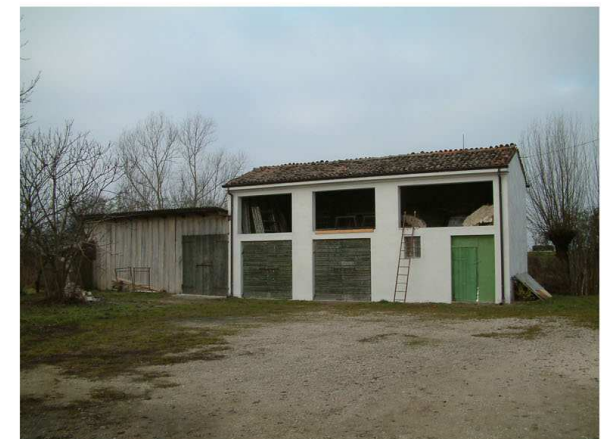
6. Edificio 3. Fronte est
