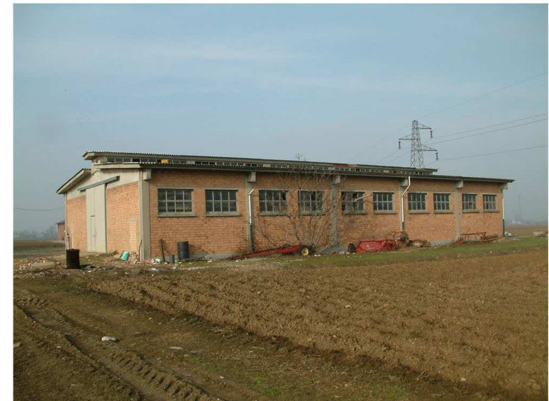
9. Edificio 4. Fronti sud ed est.
