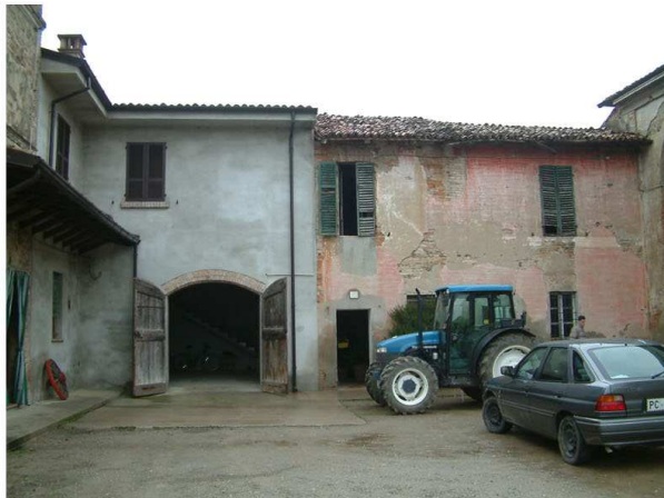
4. Edifici 1c-1d. Fronte sud
