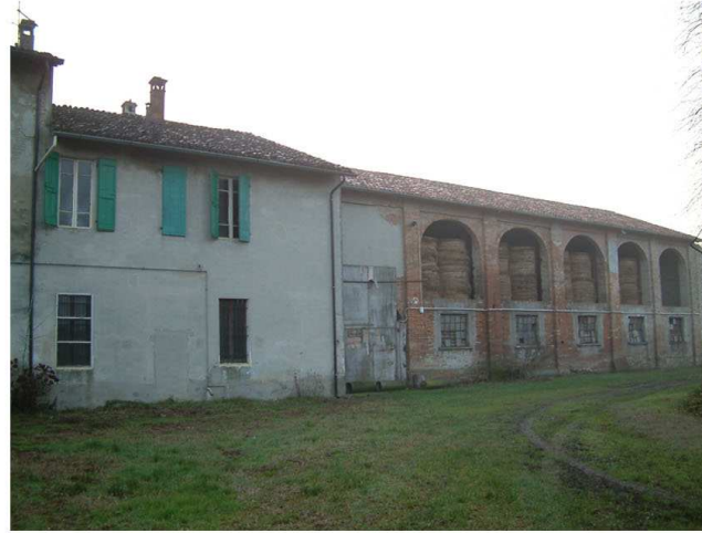
5. Edificio 1. Fronte nord
