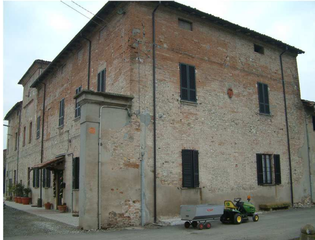
2. Edificio 1 e ingresso est.
