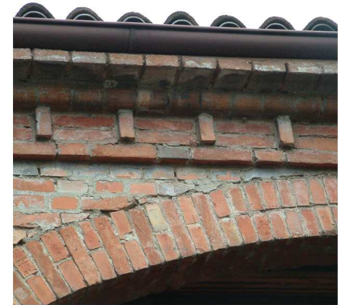
9. Edificio 2. Particolare del cornicione.
