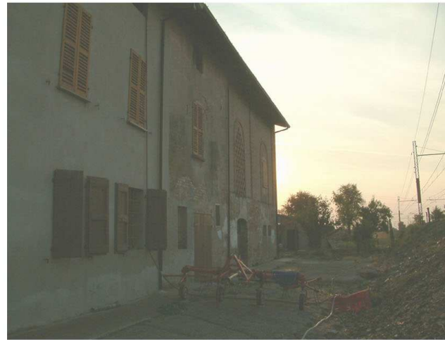
2. Edificio 1. Fronte nord.
