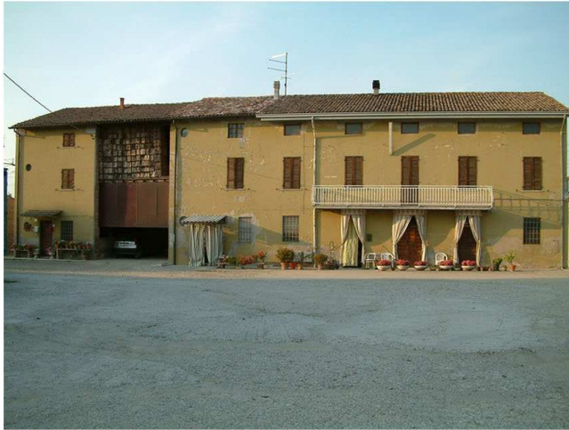
1. Edificio 1. Fronte sud.
