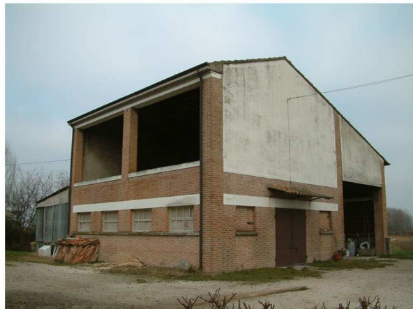
4. Edificio 2. Fronte sud-est
