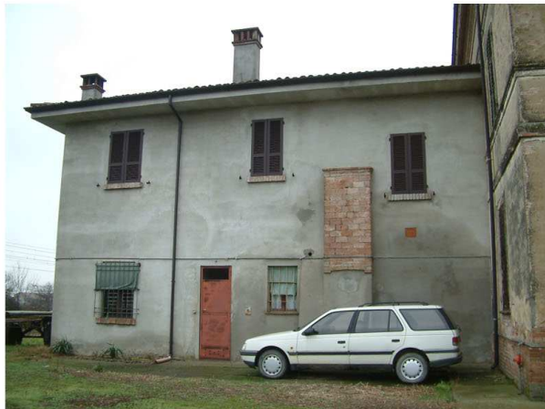
10. Edificio 1b. Fronte ovest
