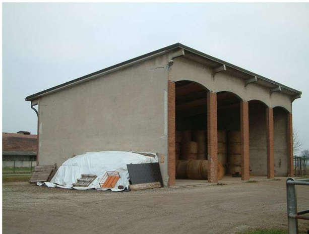
4. Edificio 3. Fronte est
