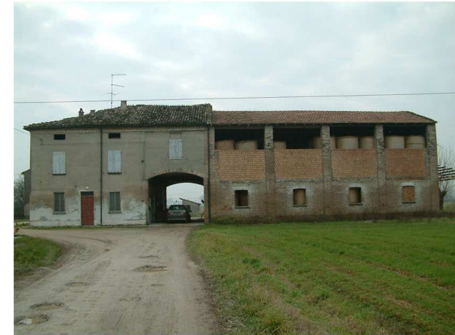
3. Edificio 1. Fronte nord.
