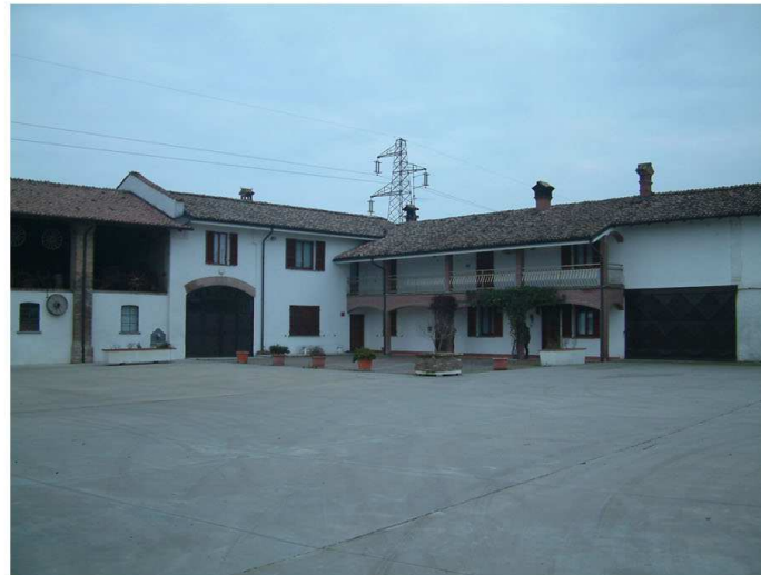
4. Edificio 1. Fronti sud e ovest.
