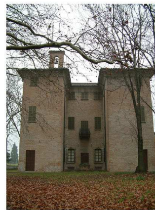
7. Edificio 1. Fronte sud
