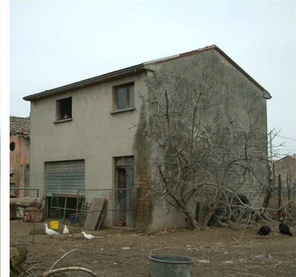
7. Edificio 2. Fronti sud ed est.
