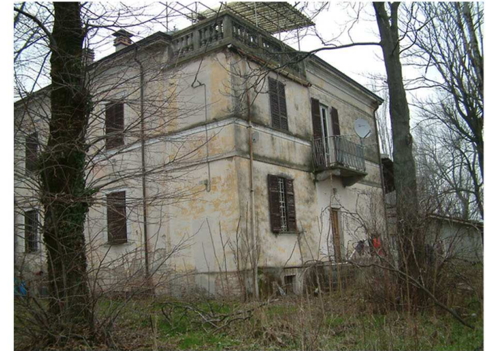
3. Edificio 1. Fronte sud-est
