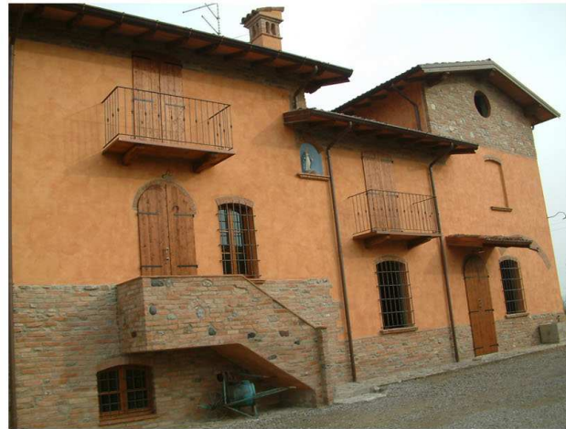
2. Edificio 1. Fronte sud
