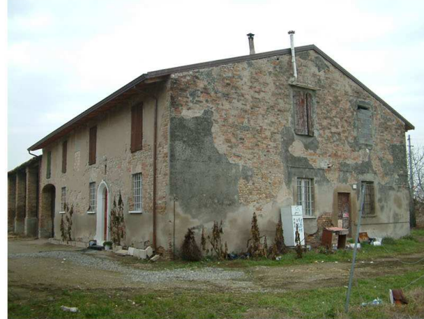
2. Edificio 1. Fronte sud-est
