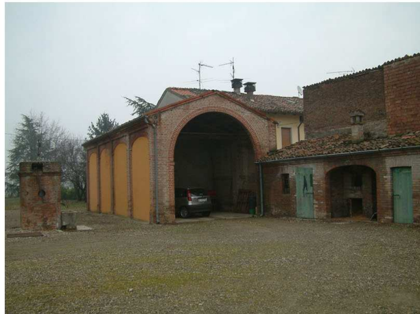
4. Edificio 2a. Fronte sud-ovest
