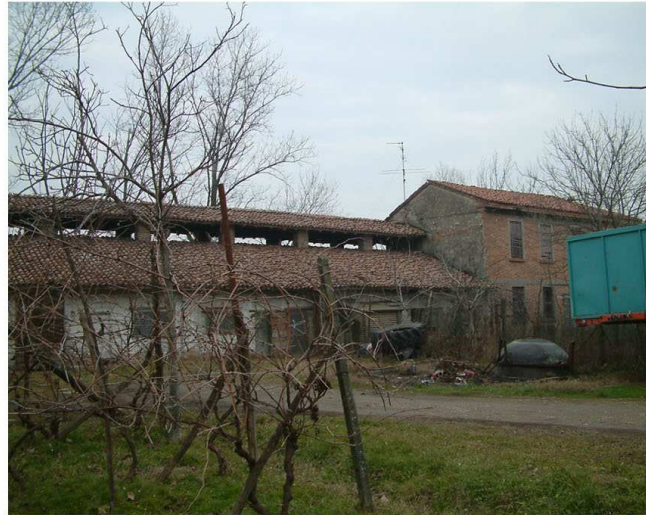
14. Edificio 6. Fronte sud.
