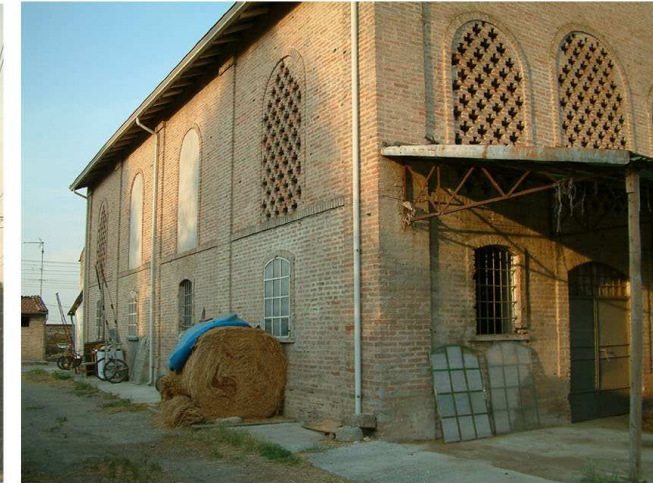
3. Edificio 2. Fronte est.
