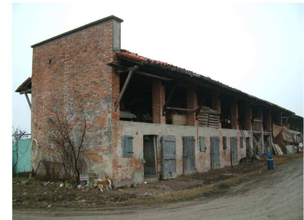
6. Edificio 8. Fronte sud
