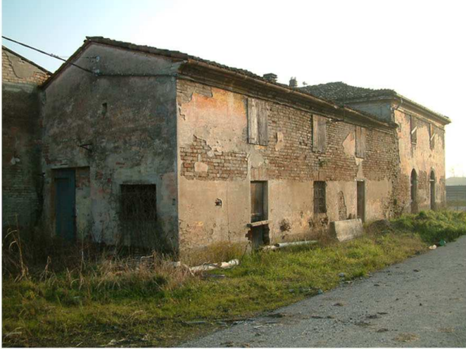
1. Edificio 1a. Fronte ovest
