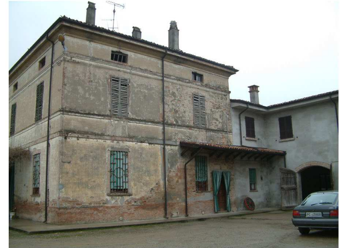
3. Edificio 1a. Fronte est
