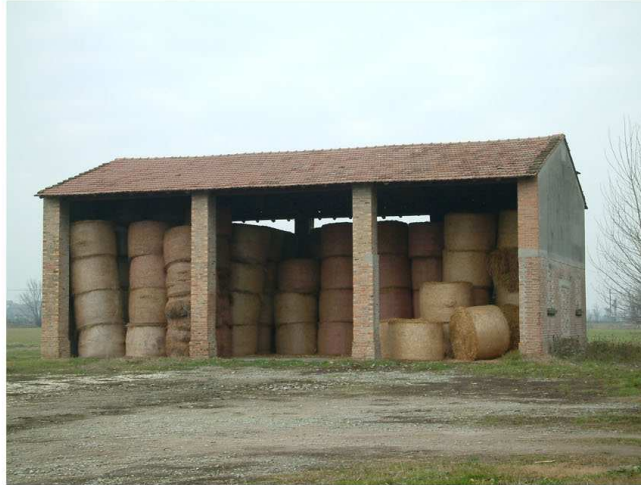
8. Edificio 2. Fronte est.
