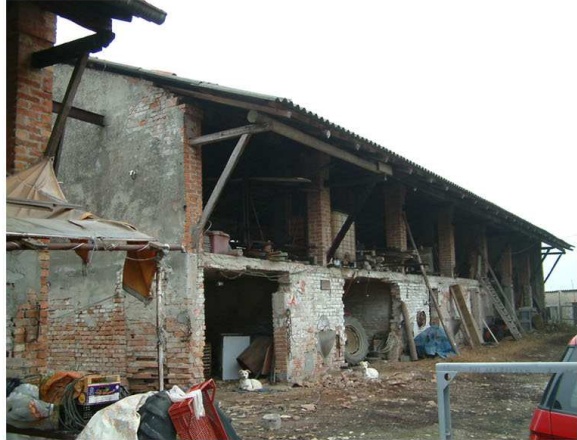
7. Edificio 5. Fronte sud
