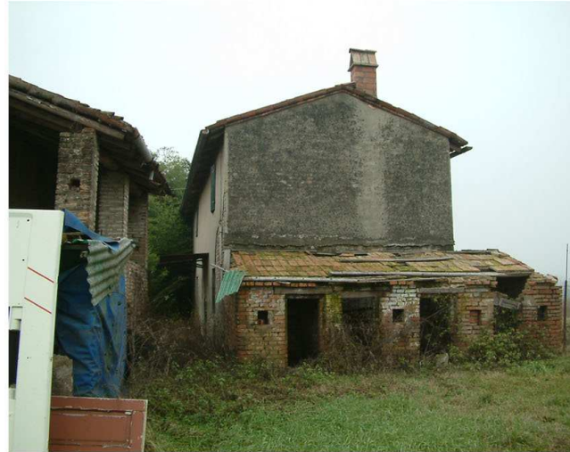
7. Edificio 2. Fronte est.
