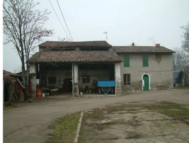
2. Edificio 1. Fronte sud
