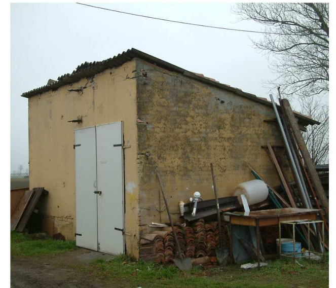
5. Edificio 3. Fronte sud.
