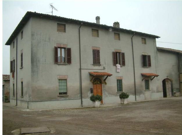
1. Edificio 1a. Fronte est
