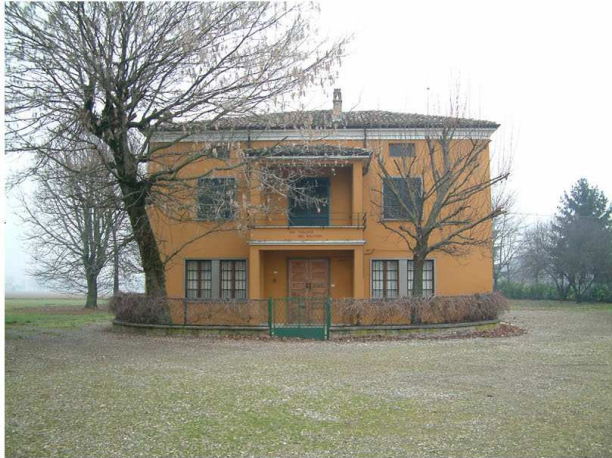
1. Edificio 1. Fronte sud
