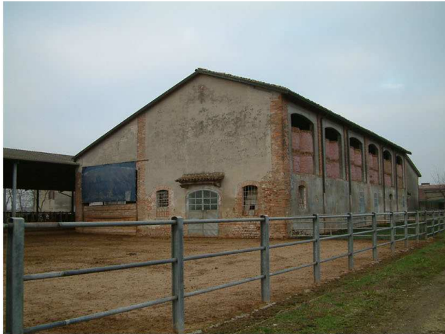
1. Edificio 1. Fronte nord-est
