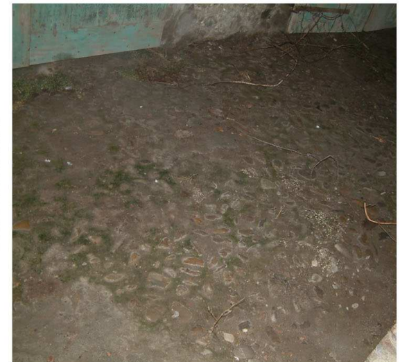
9. Edificio 3. Pavimentazione in ciottoli
