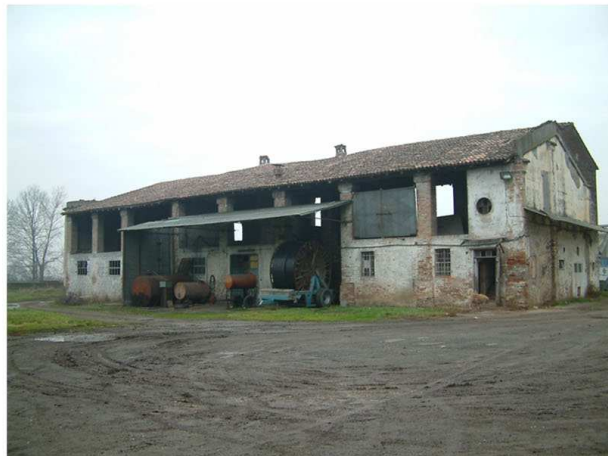
4. Edificio 2. Fronte sud
