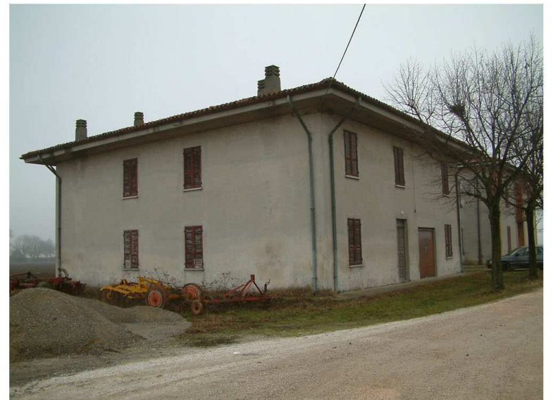
4. Edificio 3. Fronti sud e ovest.
