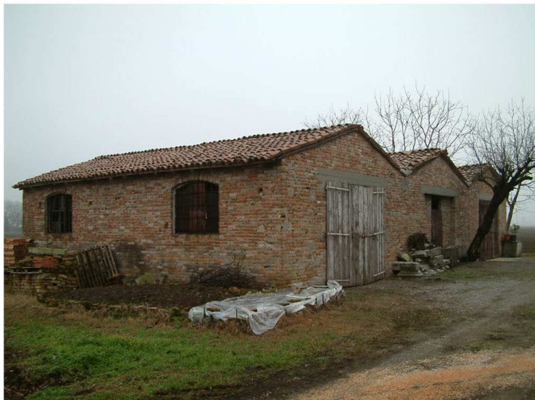
3. Edificio 2. Fronti sud e ovest.
