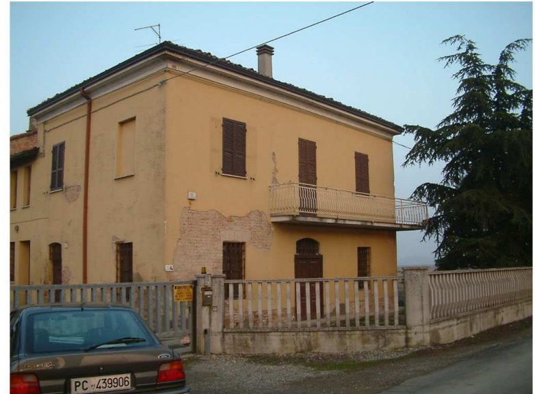
2. Edificio 1a. Fronte sud-ovest
