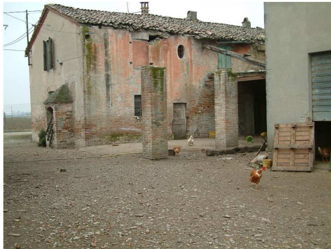
2. Edificio 1. Fronti sud ed est.
