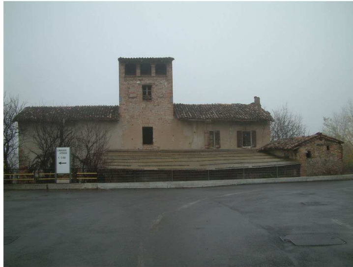
1. Edificio 1. Fronte sud.
