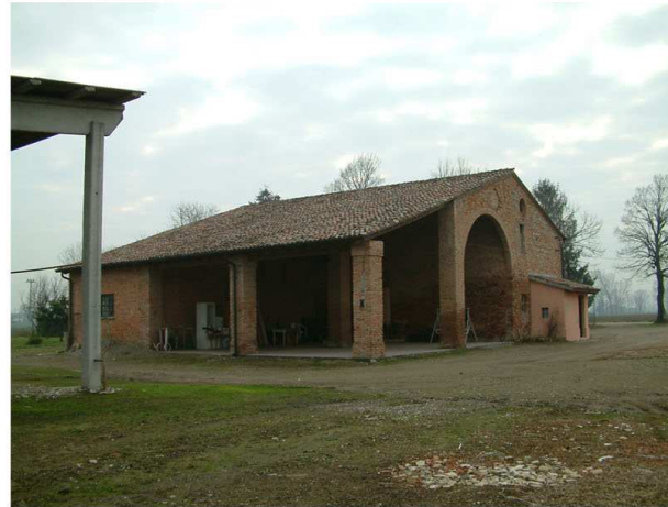
5. Edificio 2. Fronte nord-ovest
