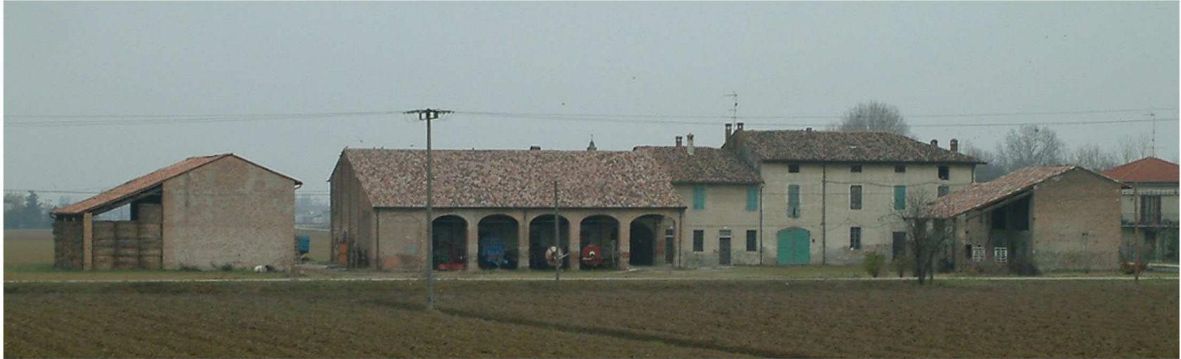
1. Vista del complesso da Sud.
