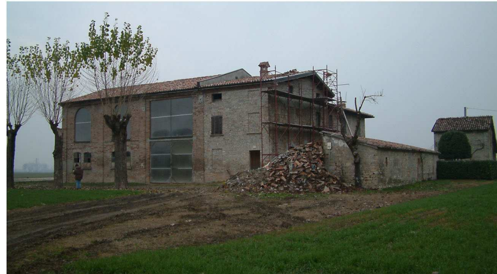
2. Complesso visto da Sud.
