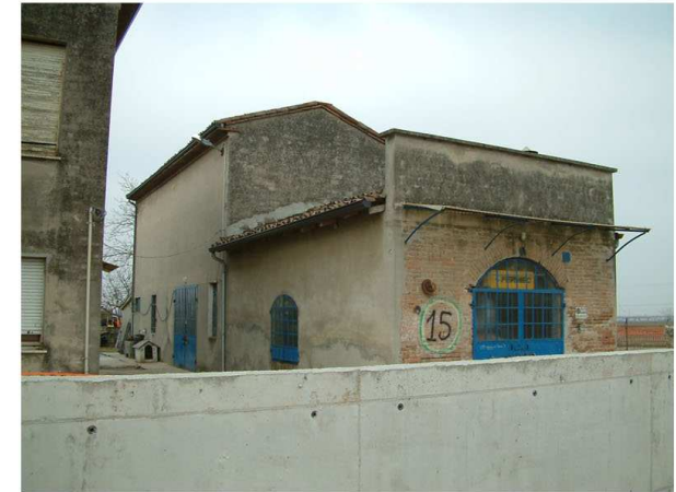
3. Edificio 2a. Fronte sud
