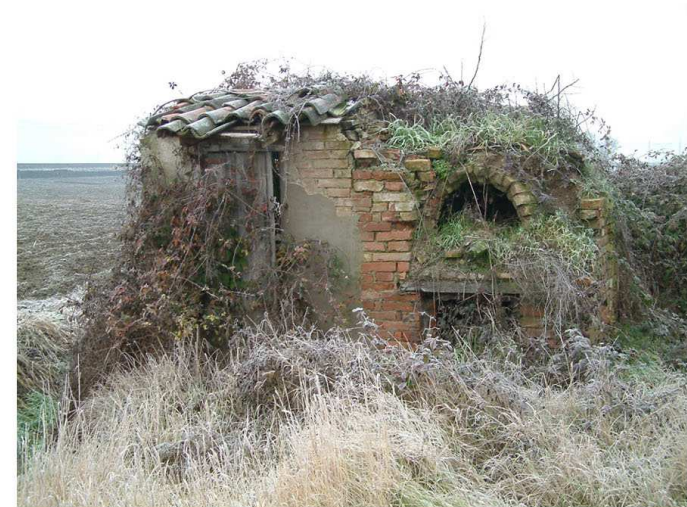
6. Edificio 3. Fronte est.
