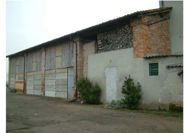
3. Edificio 1b-1c. Fronte ovest
