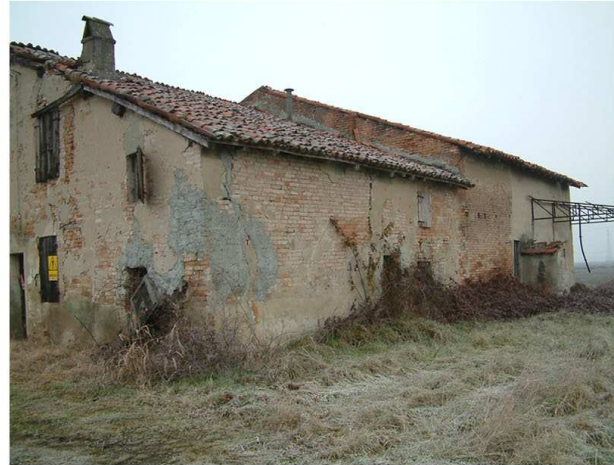
2. Edificio 1. Fronti sud ed est.
