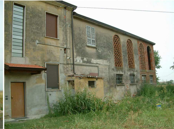
3. Edificio 1. Fronte est.
