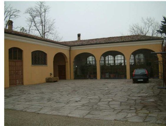
20. Edificio 2. Fronte sud-est
