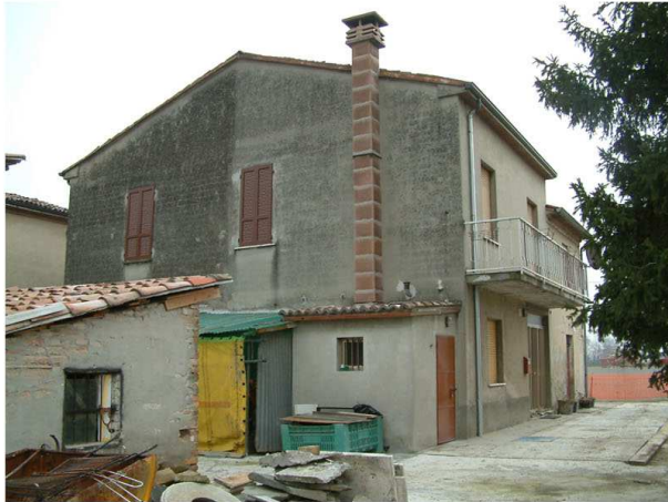
1. Edificio 1b. Fronte nord
