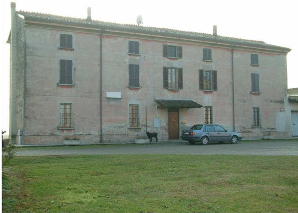
1. Edificio 1a. Fronte nord
