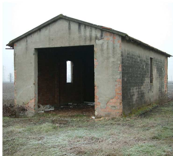
5. Edificio 2. Fronti sud ed est.
