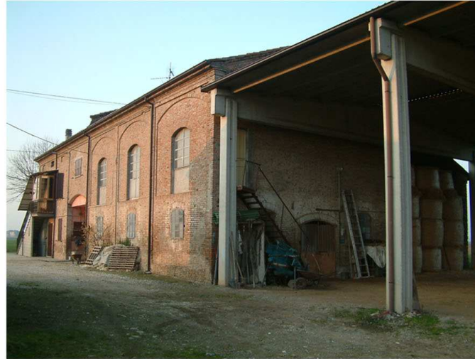
2. Edificio 1. Fronte sud
