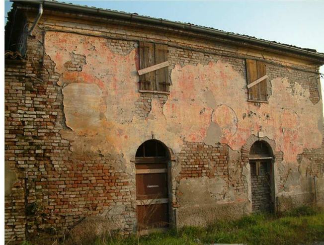
2. Edificio 1b. Fronte ovest
