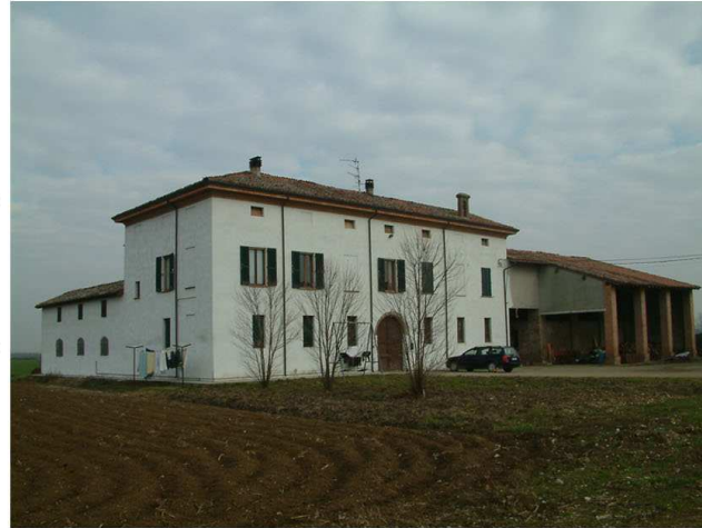
2. Edificio 1. Fronti sud e ovest.
