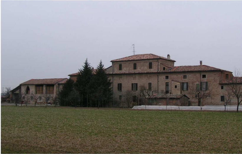
1. Edificio 1, parti 1a, 1b, 1c, 1d, 1e, 1f. Fronte sud.
