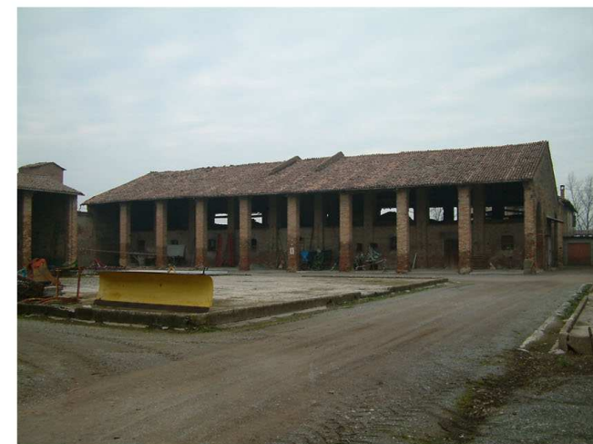
6. Edificio 2. Fronte sud.
