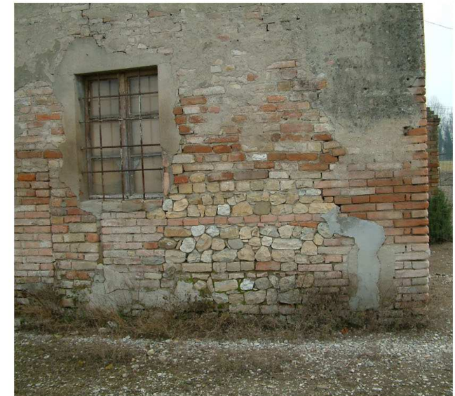
10. Edificio 1. Brano di muratura in ciottoli.
