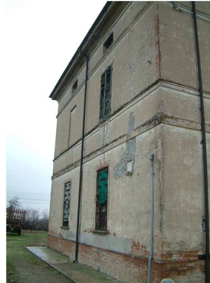
2. Edificio 1a. Fronte ovest
