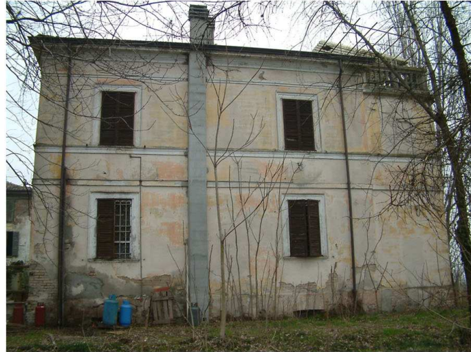
2. Edificio 1. Fronte sud
