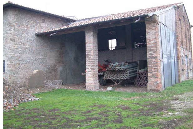
4. Edificio 1. Fronti ovest e nord.
