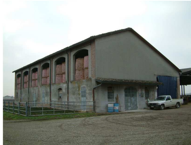
2. Edificio 1. Fronte nord-ovest
