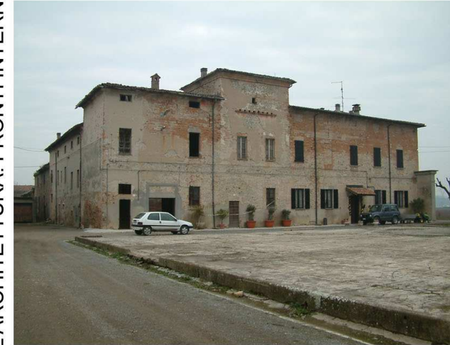
3. Edificio 1. Fronte sud.
