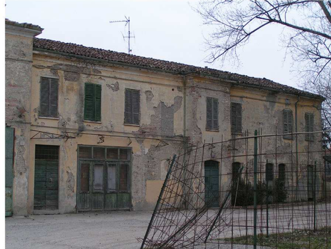
2. Edificio 1b. Fronte sud
