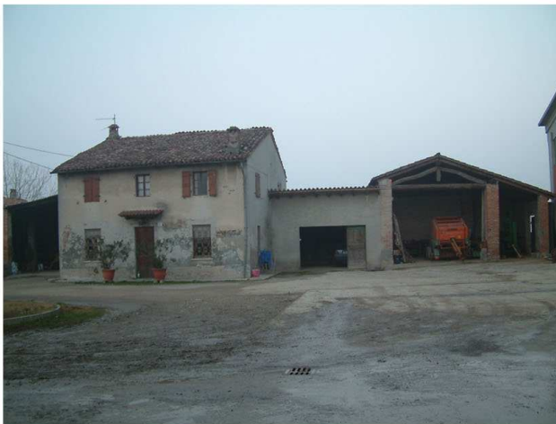
4. Edificio 1. Fronte sud.
