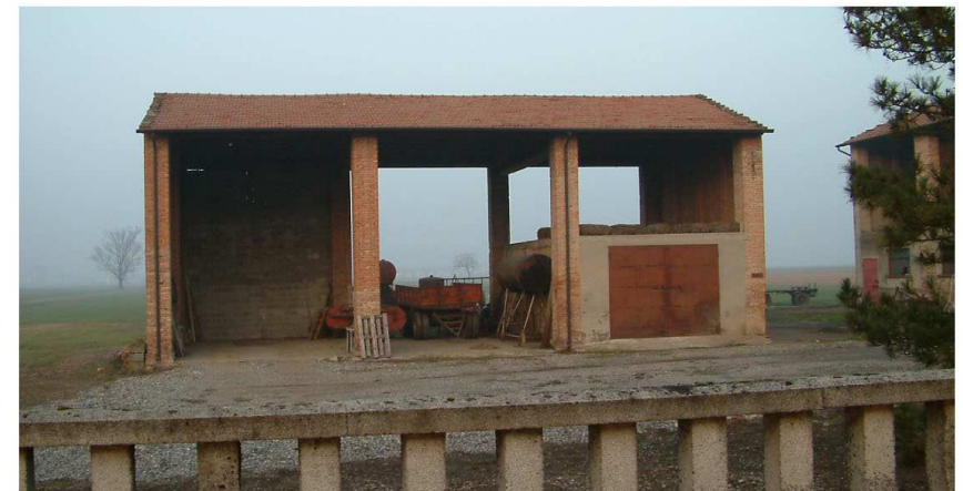
4. Edificio 2. Fronte sud
