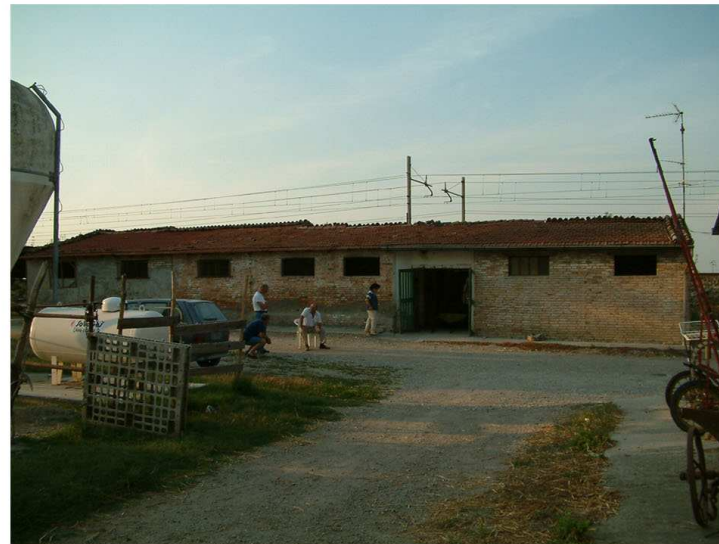
5. Edificio 4. Fronti sud.
