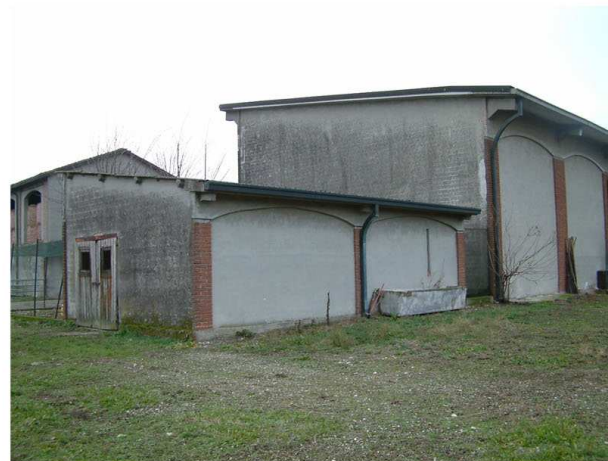
5. Edifici 3 e 4. Fronte ovest.
