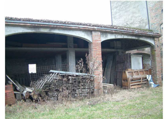
3. Edificio 1c. Fronte ovest
