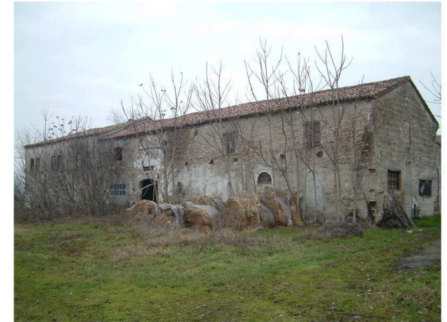
9. Edificio 4. Fronte sud
