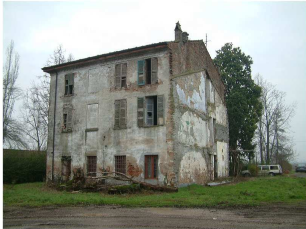
7. Edificio 3. Fronte nord-ovest
