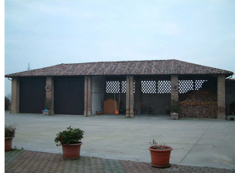
2. Edificio 2. Fronte est.
