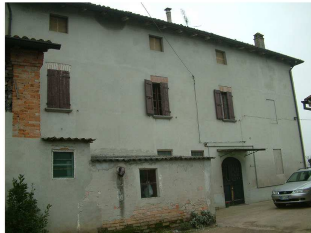
4. Edificio 1a. Fronte ovest
