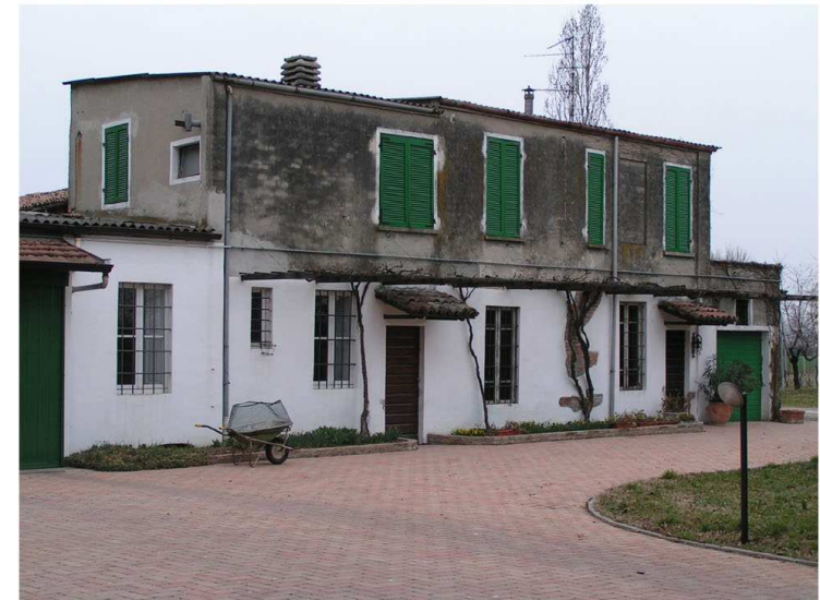
10. Edificio 4. Fronte est.
