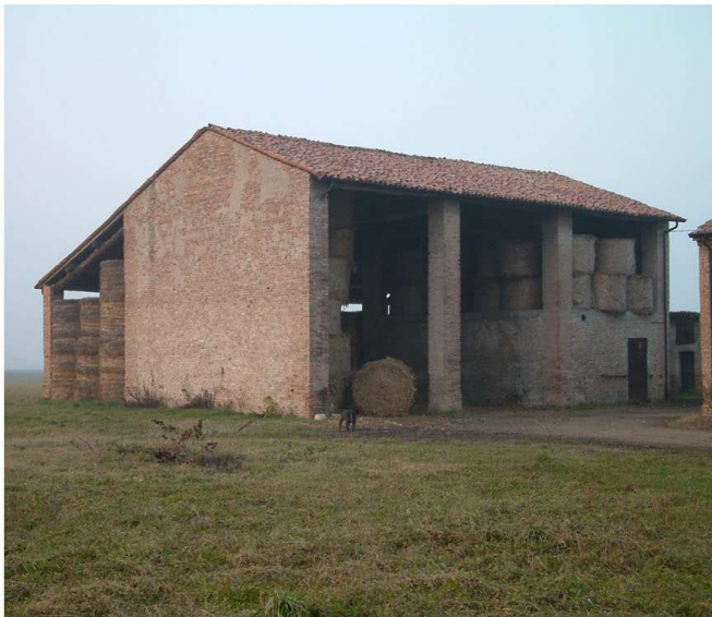
3. Edificio 2. Fronti sud e est.
