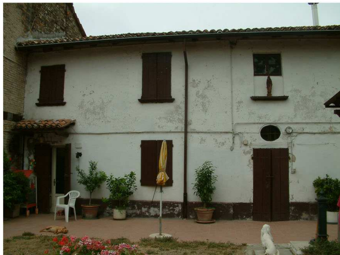
3. Edificio 1. Fronte sud
