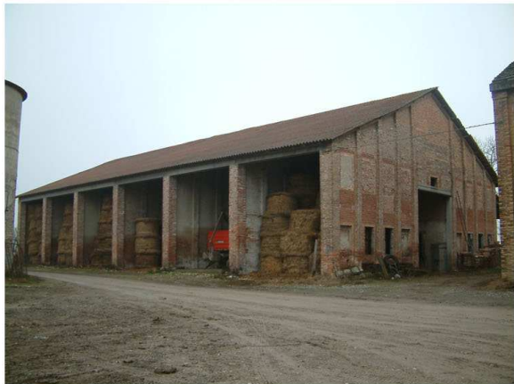
10. Edificio 6. Fronte nord-ovest
