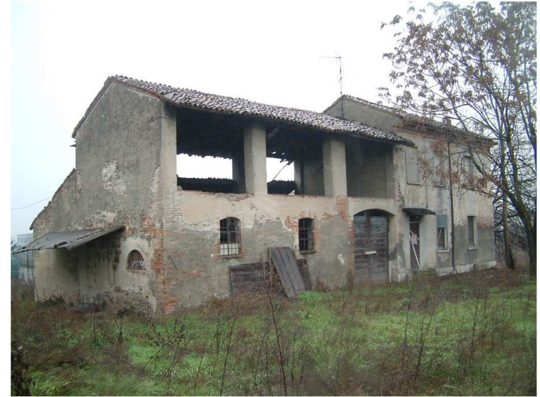
2. Edificio 1. Fronte sud
