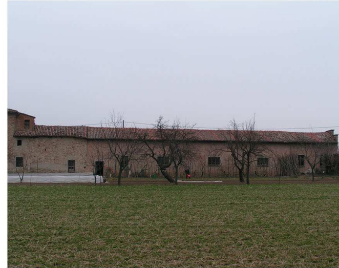
2. Edificio 1, parti 1g, 1h. Fronte sud.
