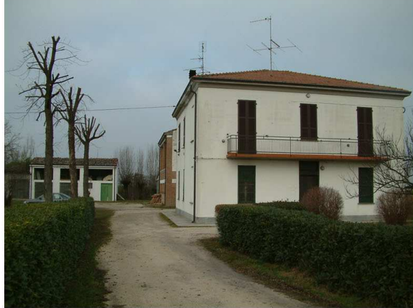
1. Edificio 1. Fronte est
