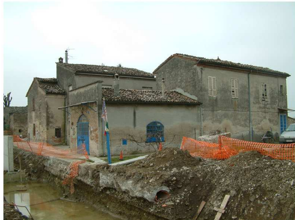
4. Edificio 2. Fronte est
