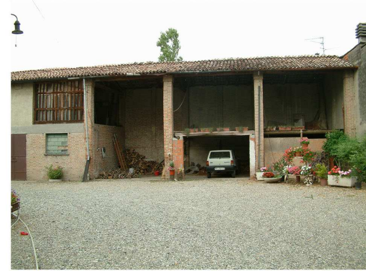
3. Edificio 2. Fronte sud.
