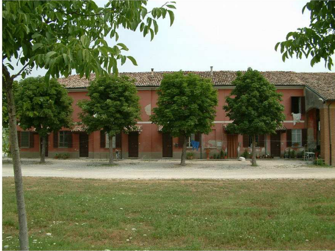
1. Edificio 1. Fronte sud
