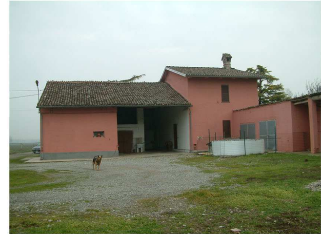
2. Edificio 1. Fronte nord
