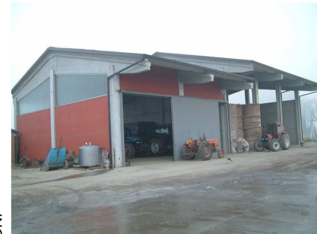
5. Edificio 2. Fronti sud e ovest.
