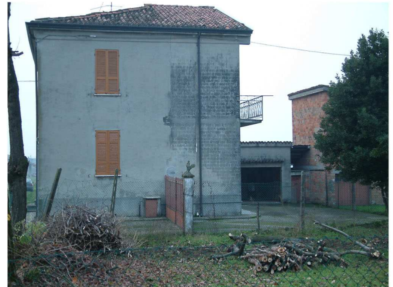
2. Edificio 1. Fronte est
