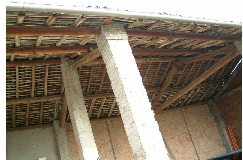
7. Edificio 3. Copertura del fienile.
