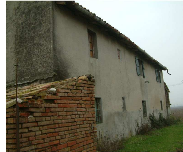
8. Edificio 2. Fronte nord.
