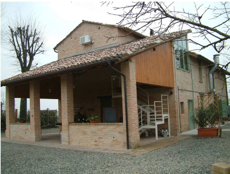
3. Edificio 1. Fronte sud-est
