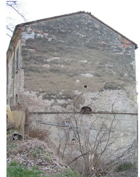
3. Edificio 1b. Fronte est
