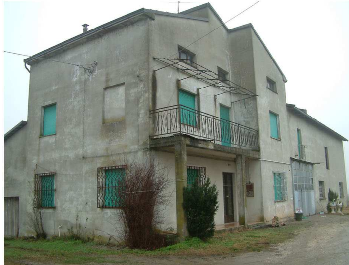
5. Edificio 1. Fronti nord-ovest e sud-ovest.
