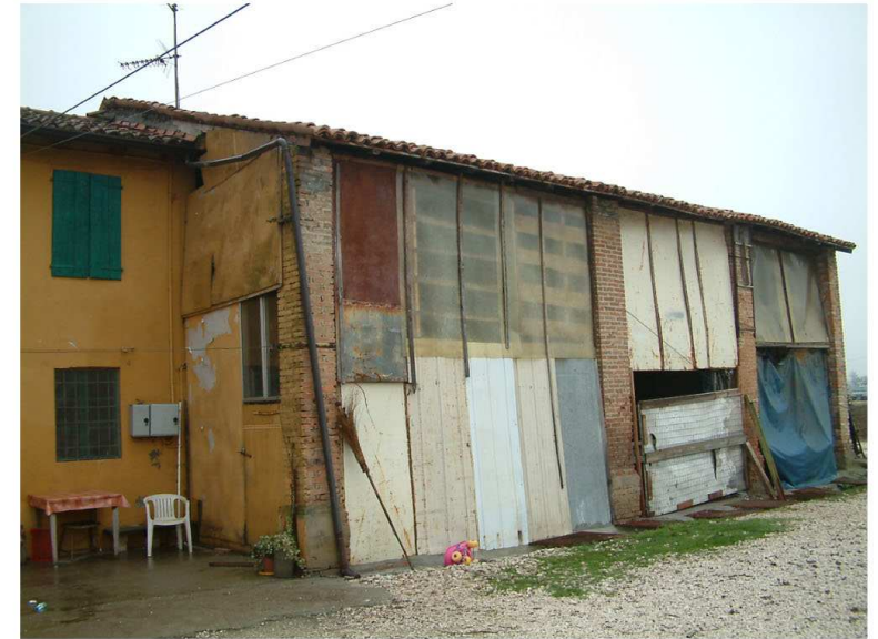
2. Edificio 1. Fronte sud.
