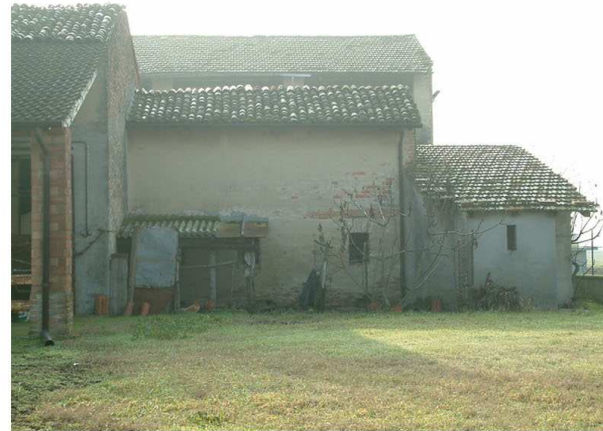
8. Edifici 2c-2d. Fronte sud
