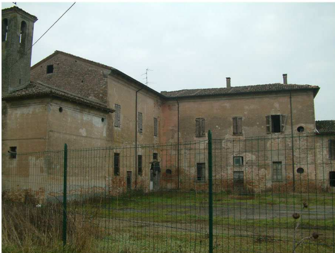
4. Edificio 1a+1b. Fronti nord ed est.
