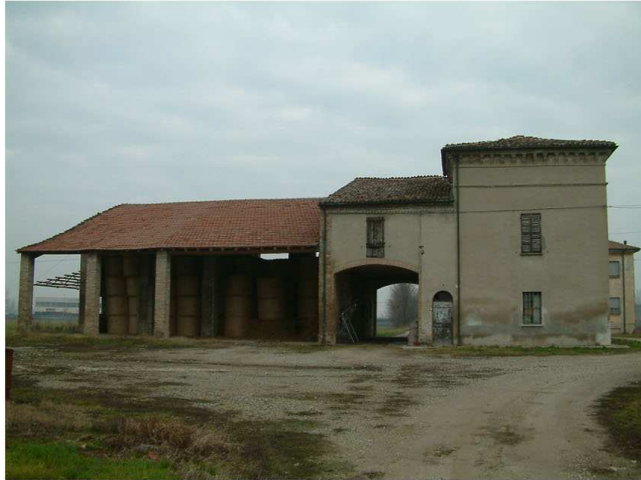
1. Edificio 1. Fronte sud.
