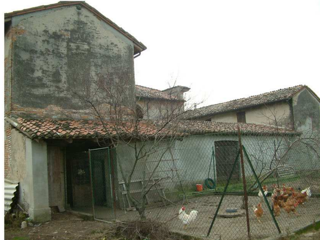
5. Edificio 1. Fronte nord.
