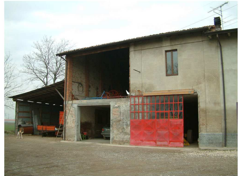
2. Edificio 1. Fronte sud
