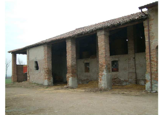
3. Edificio 1. Fronte sud
