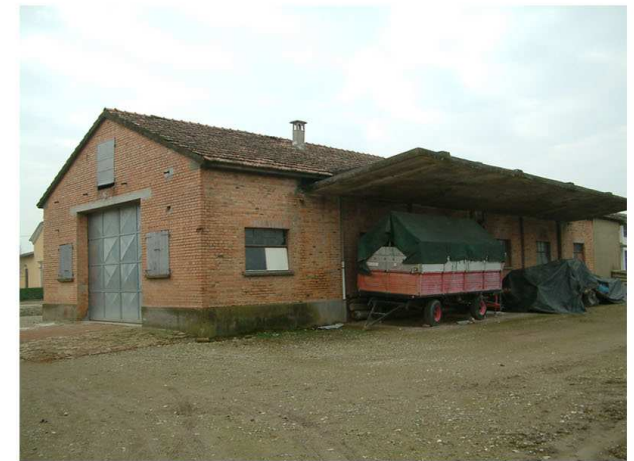
6. Edificio 3. Fronte sud
