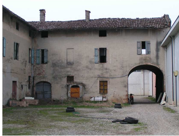
2. Edificio 1a-1b. Fronte est
