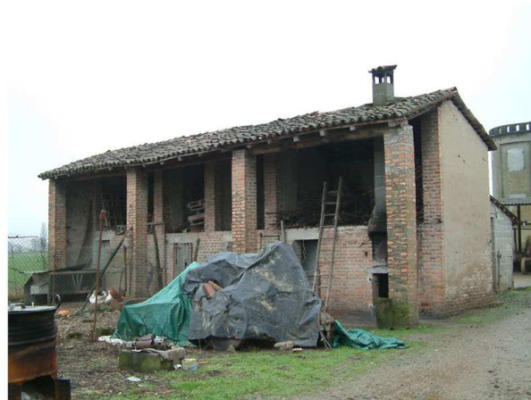
11. Edificio 2. Fronte nord
