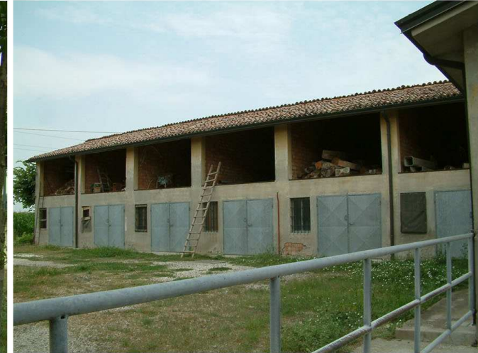
3. Edificio 2. Fronte sud
