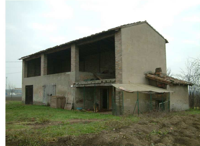
9. Edificio 3. Fronti sud e ovest.
