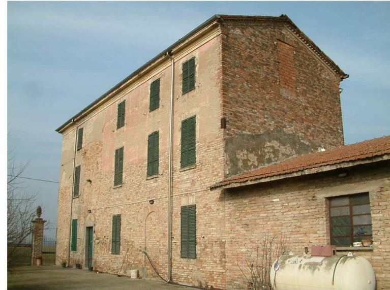
2. Edificio 1. Fronte sud.
