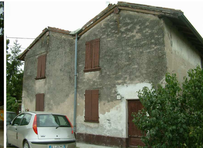
5. Edificio 1. Fronte est.
