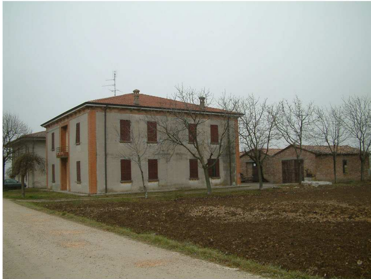
1. Vista sud-est del complesso
