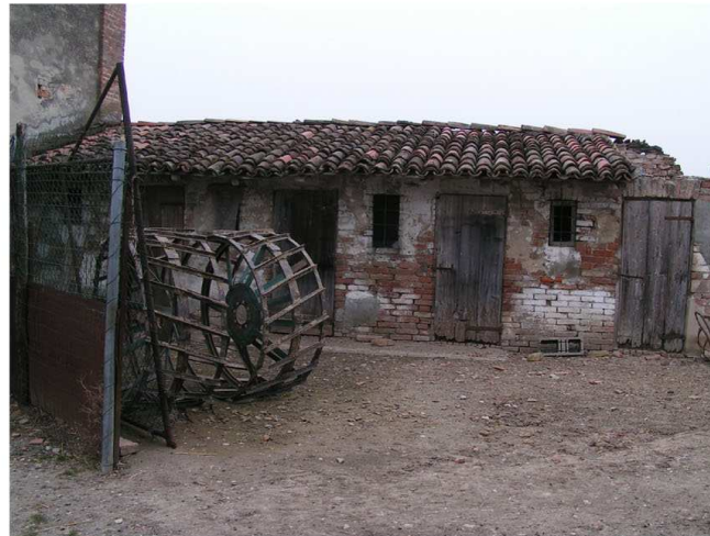
5. Edificio 2, parte 2c. Fronte est.
