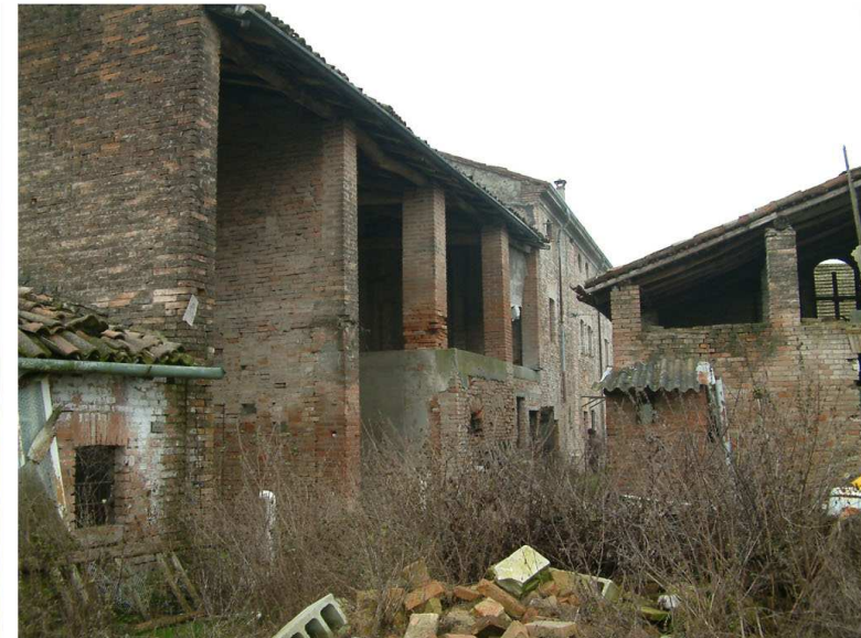
2. Edificio 1. Fronte nord. Edificio 3. Fronte est.
