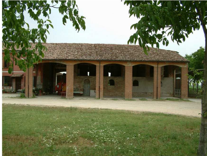
2. Edificio 1d. Fronte sud
