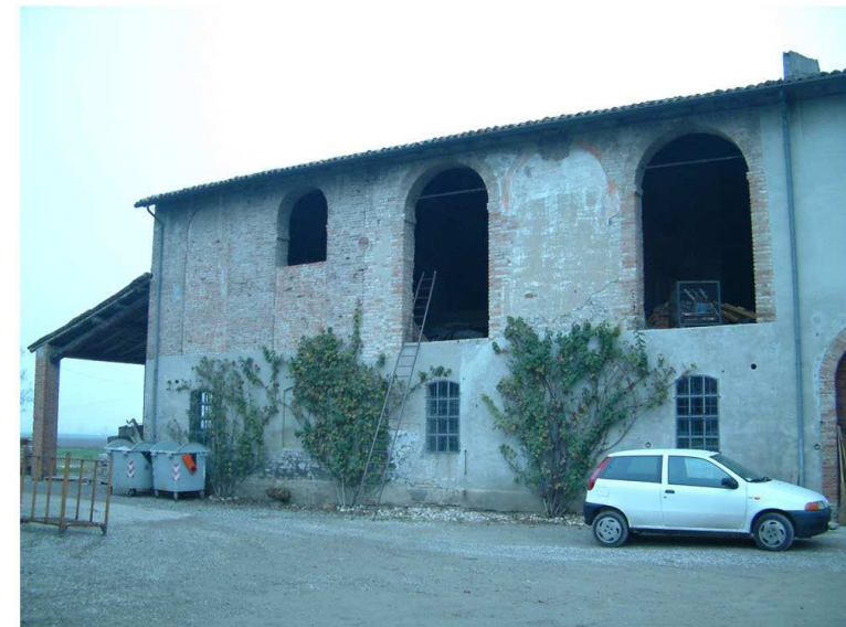
5. Edificio 1d. Fronte sud
