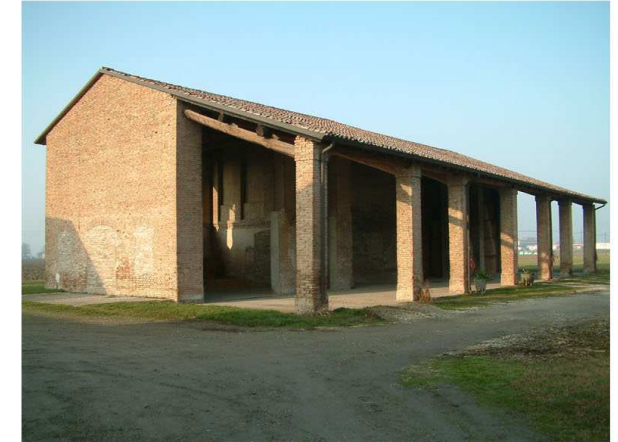
3. Edificio 2. Fronte est
