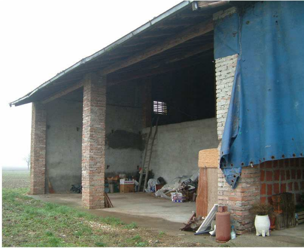
1. Edificio 1. Fronte nord-es
