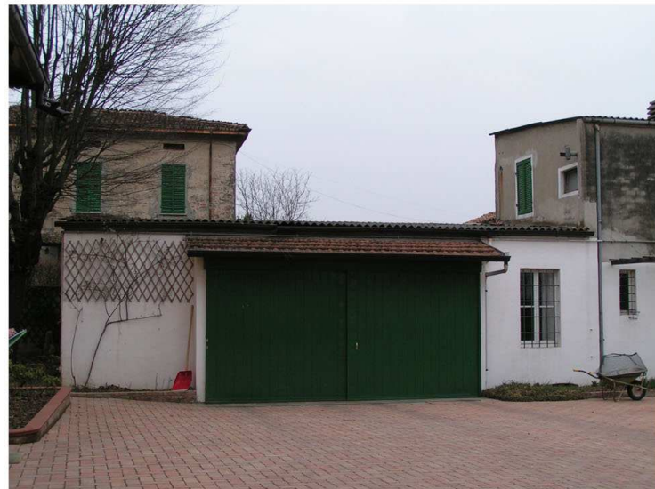
9. Edificio 4. Fronte est.
