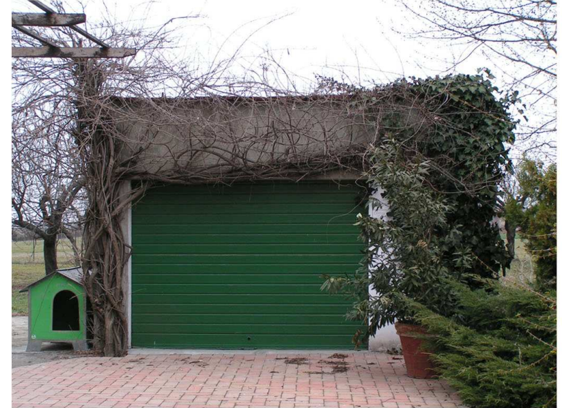
8. Edificio 5. Fronte sud.
