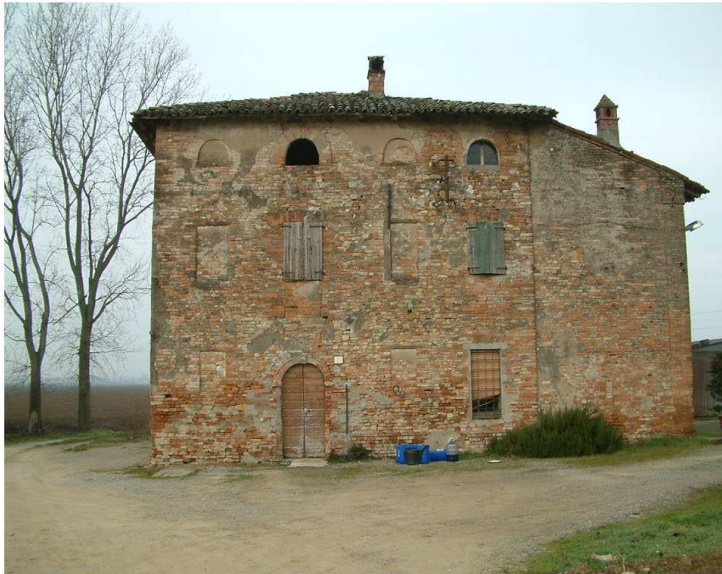
1. Edificio 1. Fronte est.
