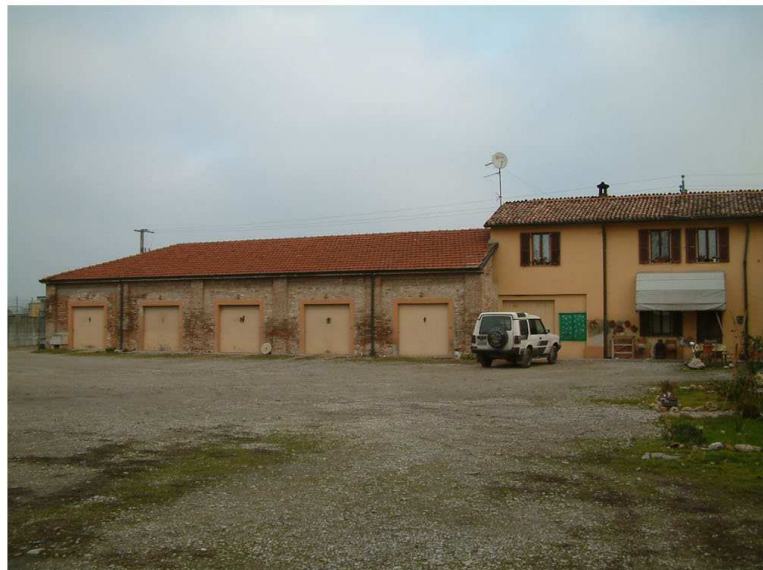
3. Edificio 1a. Fronte sud
