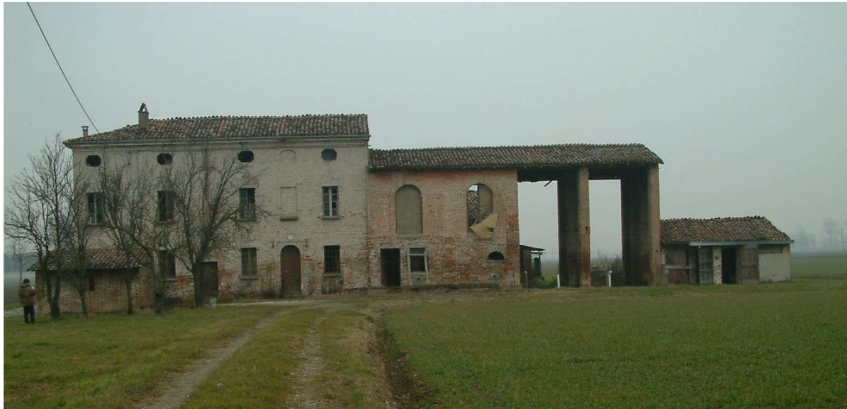
1. Edificio 1. Fronte sud.
