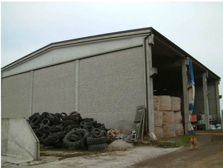
10. Edificio 3. Fronti sud e est.
