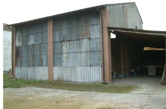
5. Edificio 2. Fronte nord
