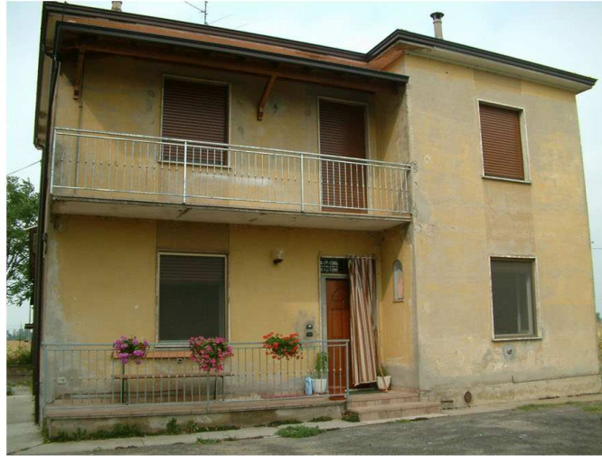
2. Edificio 1. Fronte sud.
