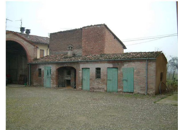
3. Edificio 2b. Fronte ovest
