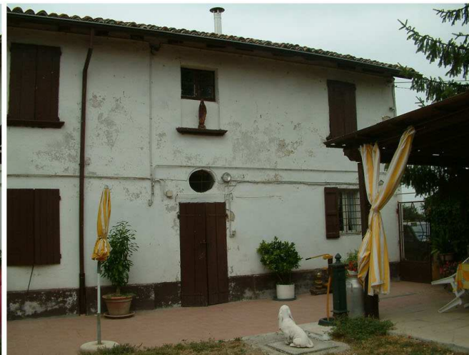
4. Edificio 1. Fronte sud
