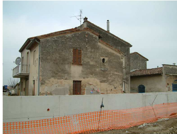
2. Edificio 1a. Fronte sud
