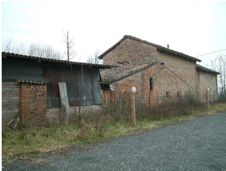
3. Edificio 1. Fronte est
