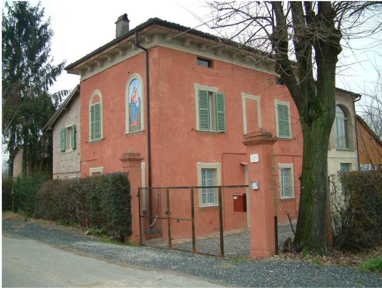
1. Edificio 1. Fronte nord-ovest
