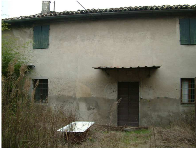
6. Edificio 2. Fronte sud.
