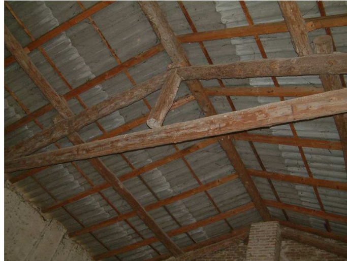
8. Edificio 2. Particolare della copertura
