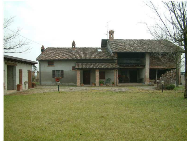
2. Edificio 1. Fronte sud
