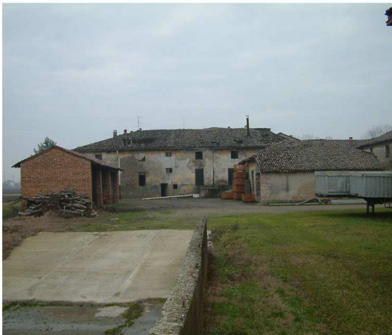
10. Edifici 1 e 5. Fronte nord.
