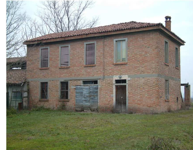
15. Edificio 6. Fronti sud ed est.
