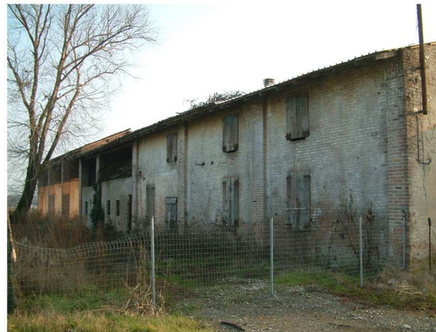
5. Edifici 1e-1f-1g. Fronte nord
