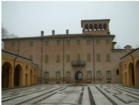
5. Edificio 1. Fronte est
