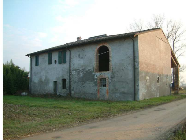
2. Edificio 1. Fronte nord-ovest
