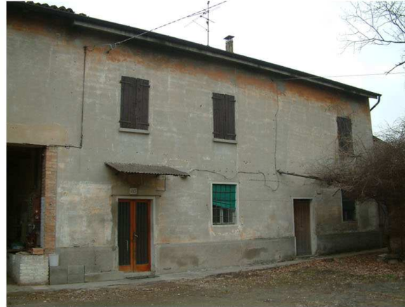
2. Edificio 1a. Fronte sud
