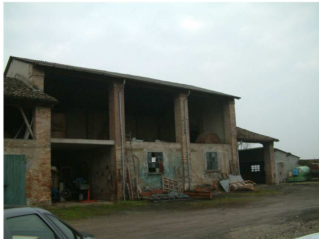
4. Edificio 1a+1b+1c. Fronte nord.
