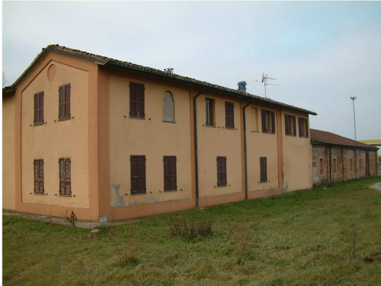
1. Fronte verso strada
