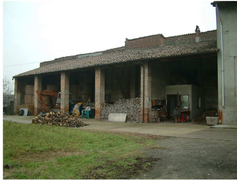
2. Edificio 1h. Fronte ovest
