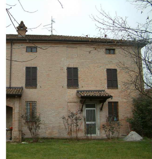
3. Edificio 1. Fronte est.
