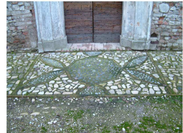
11. Pavimentazione ingresso est
