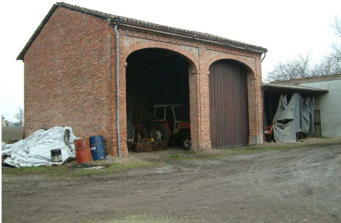
7. Edificio 2. Fronte Sud
