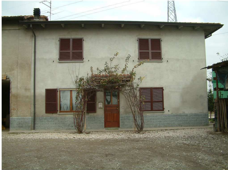
1. Edificio 1. Fronte sud
