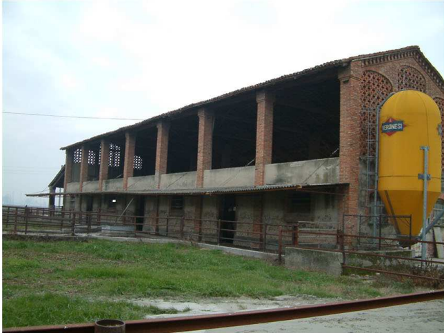
7. Edificio 3. Fronte sud.
