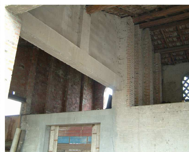
6. Fienile. Parte vecchia e parte ricostruita.
