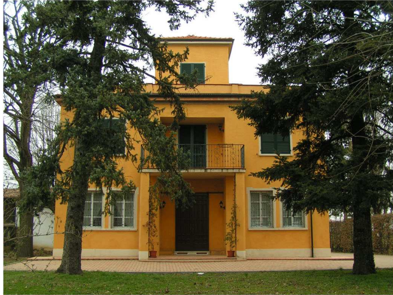
7. Edificio 3. Fronte sud.
