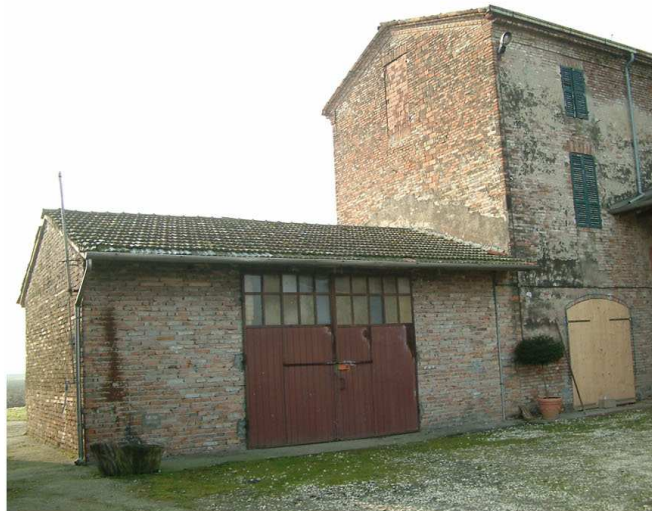
4. Edificio 1. Fronte nord.
