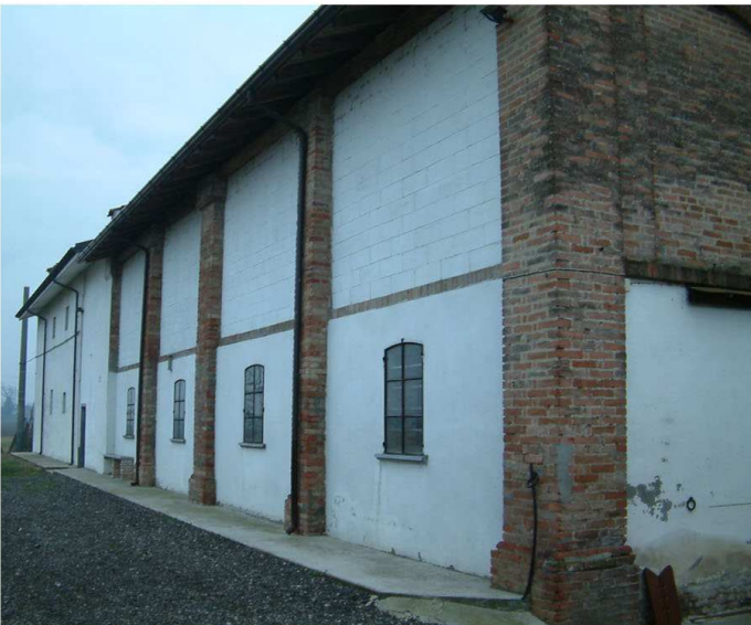
9. Edificio 1. Fronte nord.
