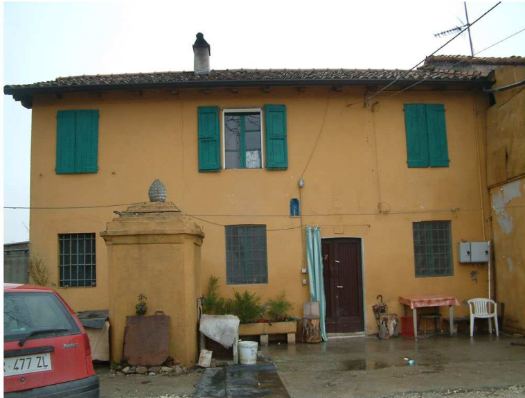
1. Edificio 1. Fronte sud.
