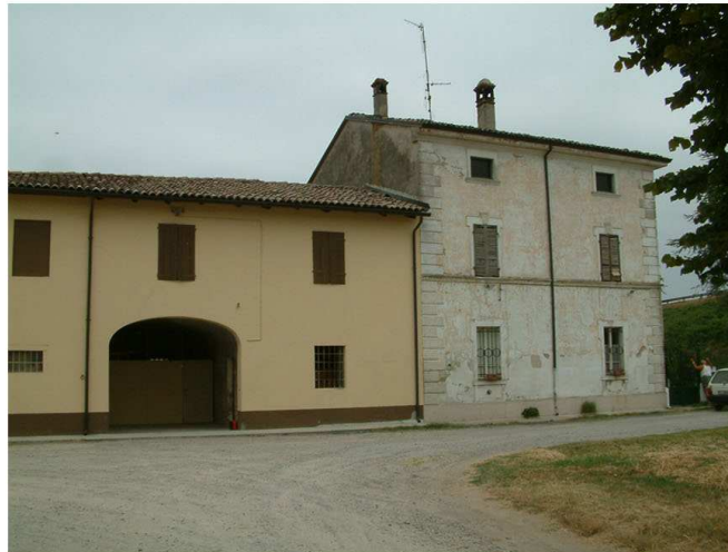
3. Edificio 1. Fronte sud.
