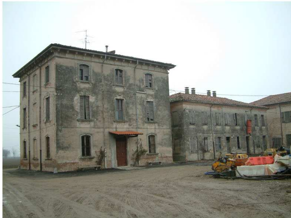
4. Edifici 1-2. Fronte est
