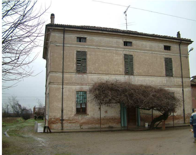
1. Edificio 1a. Fronte sud
