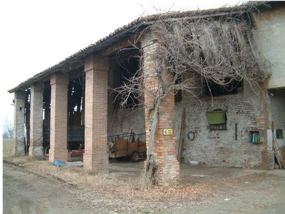
1. Edificio 1c. Fronte sud
