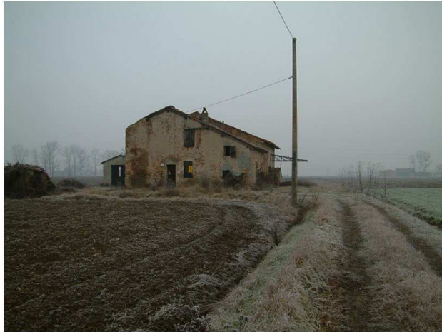
1. Complesso visto da Sud.
