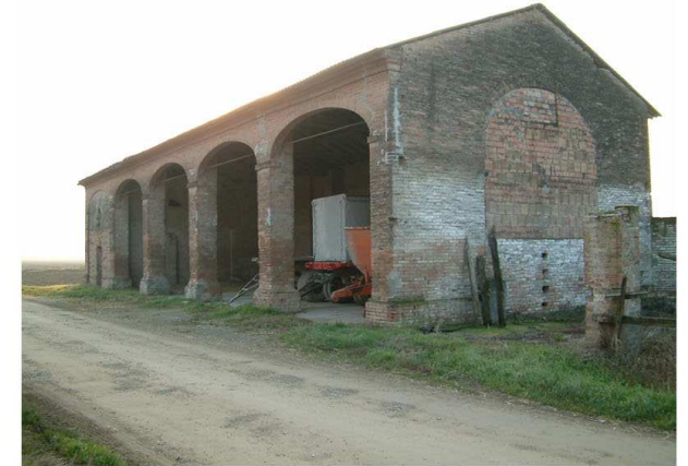
3. Edificio 2. Fronte nord-est
