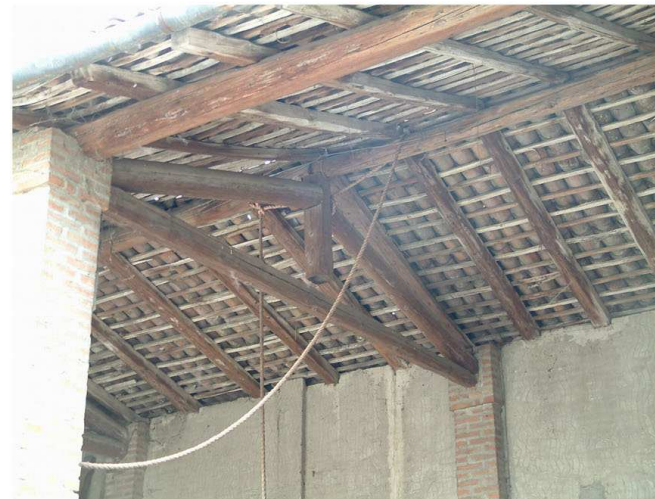
5. Edificio 2. Copertura del fienile.
