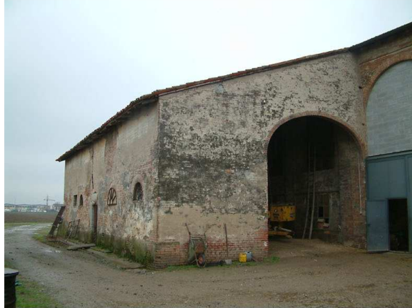
7. Edificio 1l. Fronte nord-est
