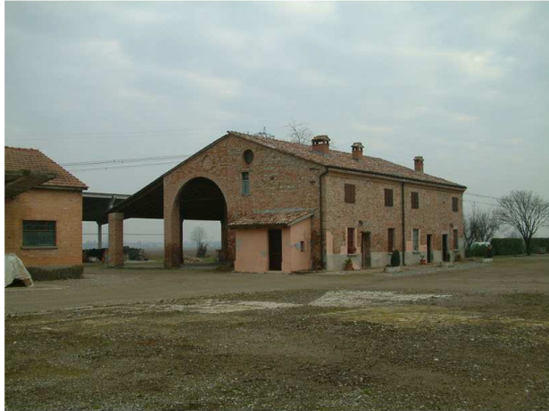
4. Edificio 2. Fronte sud-ovest
