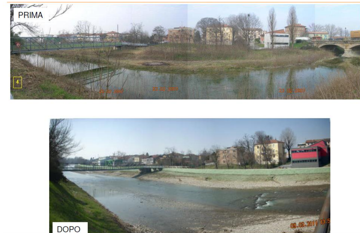
Figura 4.7.2.3 – Intervento di risagomatura ed arginatura tratto a monte della Via Emilia del T.Arda (da presentazione Ing. C.Francia Convegno – Geofluid 2014)
